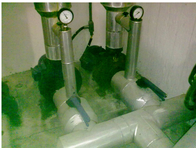
3.12. Bombas centrífugas
