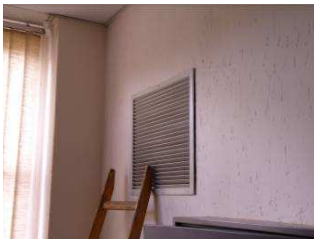
Fig. 3.13. Tomadas de ar de retorno
