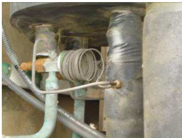
Fig. 3.20. Válvula de Expansão
