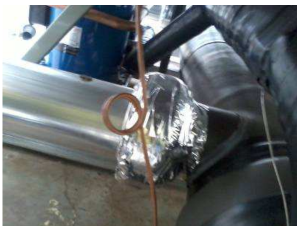
Fig. 3.30. Válvula de Expansão
