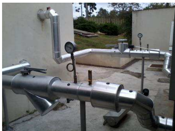
Fig. 3.27. Circulação de água – sistema reformado
