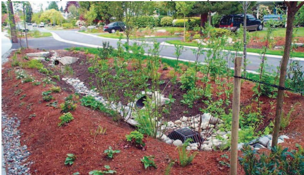
Figura 10 - Exemplo de medida de baixo impacto para retenção do escoamento superficial
