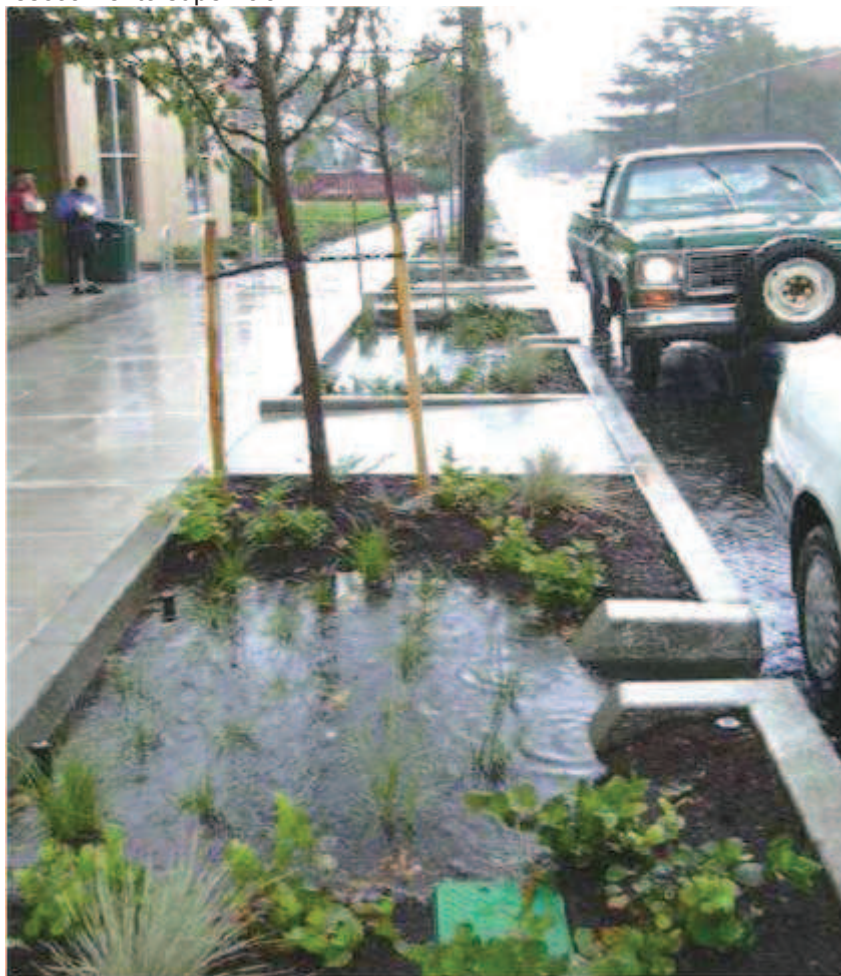
Figura 11 - Exemplo de medida de baixo impacto para retenção do escoamento superficial
