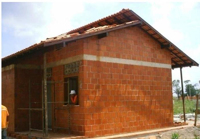
FIGURA 11 – Casa construída com resíduo do processo Bayer.
