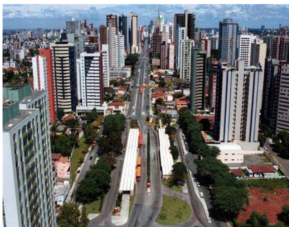
Figura 10: Setor Estrutural Norte.
