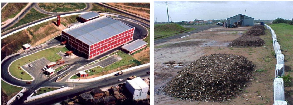
Figura 49 – Estação de Transbordo de Salvador e Unidade de Compostagem, respectivamente Fonte: PMS (2010).
