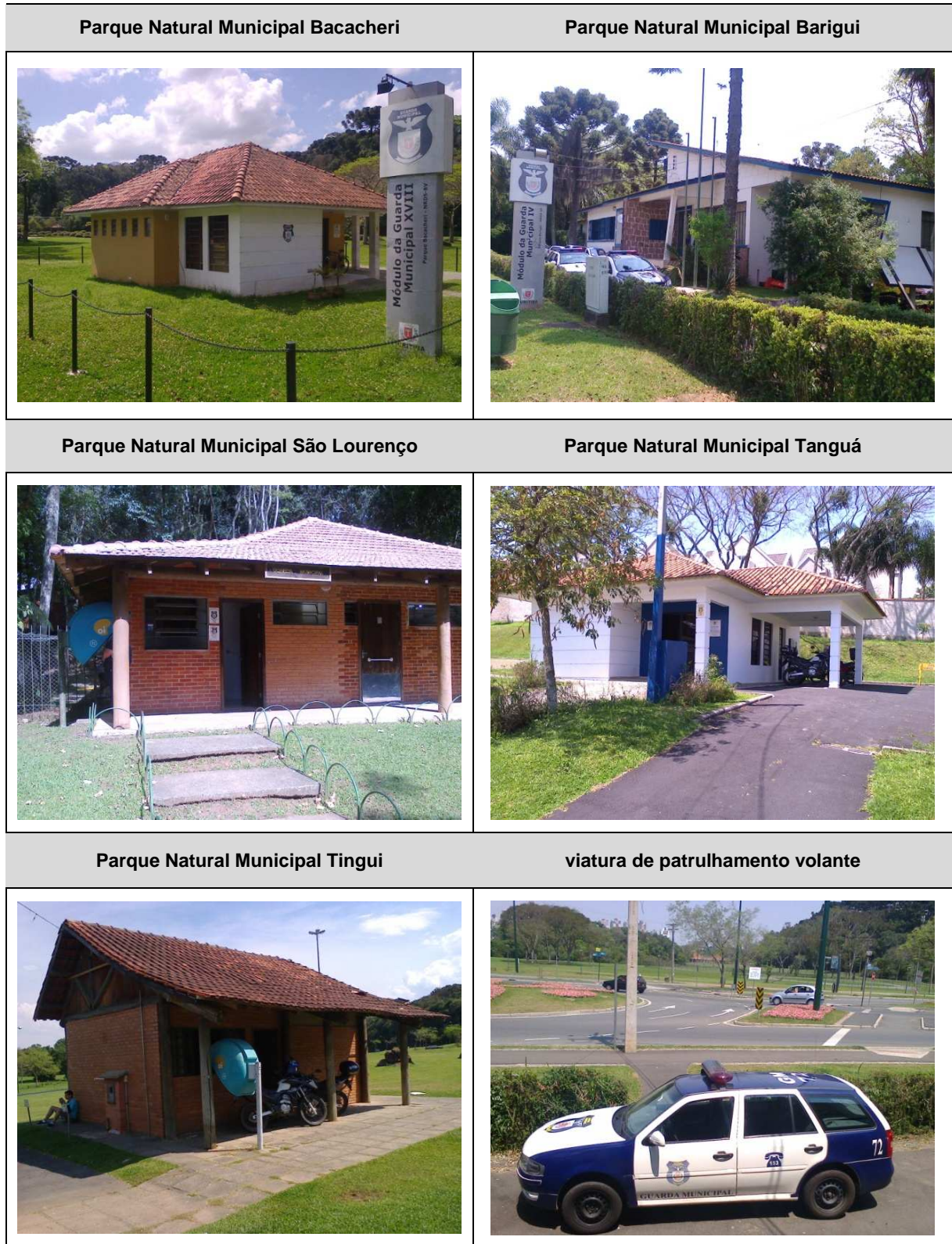
Figura 20: Vistas de instalações físicas da Guarda Municipal nas unidades de conservação estudadas e do modelo de viatura utilizada no patrulhamento
