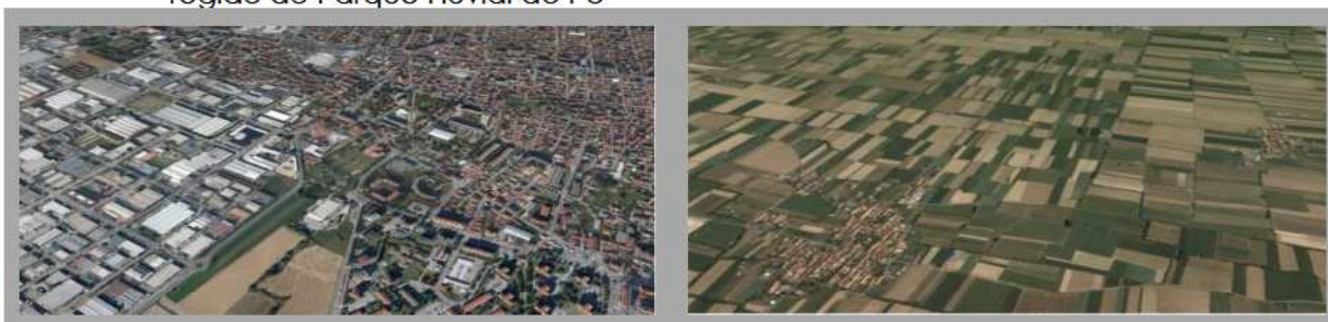
Figura 68: Vistas de áreas de atividades urbanas (esquerda) e agropecuárias (esquerda) responsáveis pela predominância da classe de baixa fragilidade biológica na região do Parque Fluvial do Po
