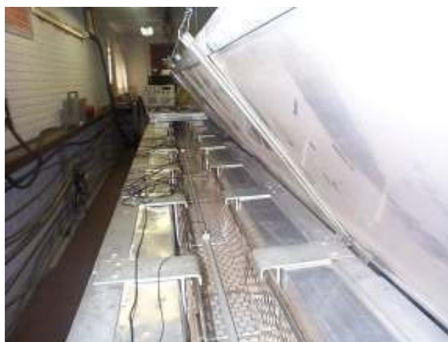
Figura 3.5– Vão de 13,8m instrumentado com acelerômetros DC
