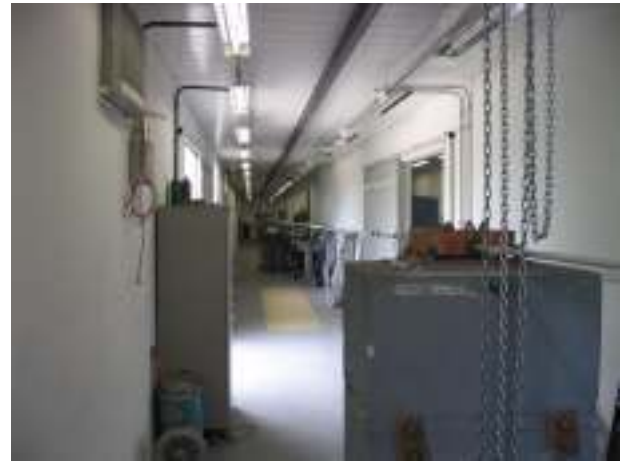
Figura 2.8 – Vista geral lado ancoragem móvel da Bancada de Vibrações
