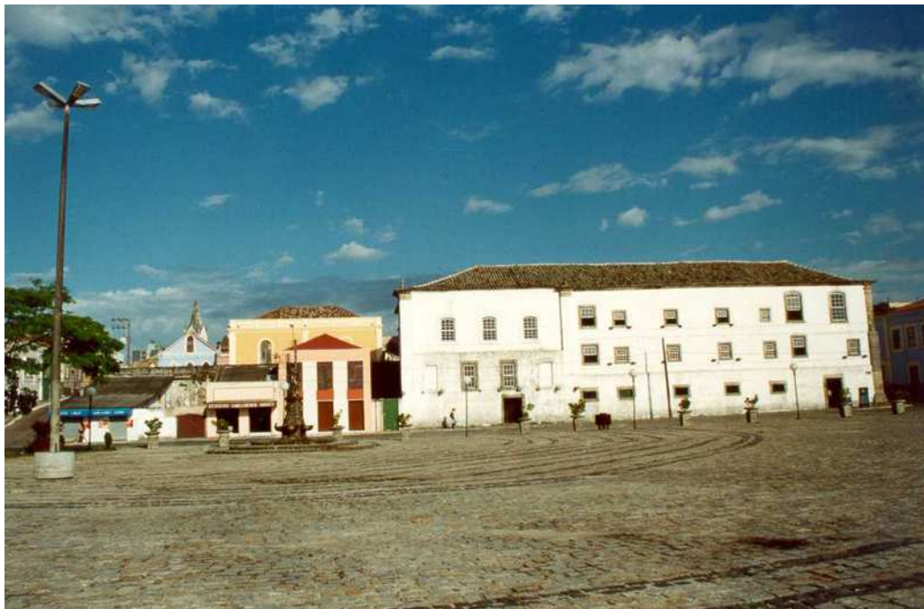
Figura 4 – Edifício do Colégio Jesuíta de Paranaguá
