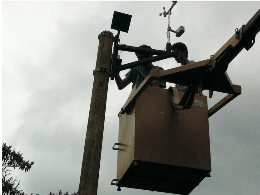
Figura 4.10: Instalação dos sensores
