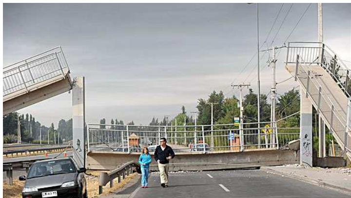
Figura 1.1 – Viaduto destruído pelo terremoto no Chile em 2010 (8.8 na escala Richter)
