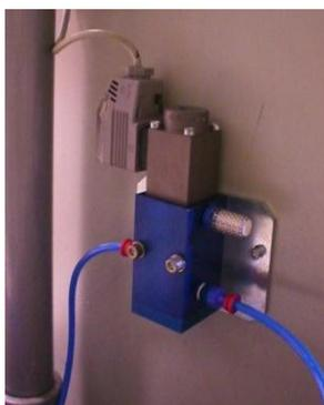
Figura 12 – Válvula Pneumática Linear Com Atuador Eletrônico. FESTO, modelo MPP – 3 – 1/8 .
