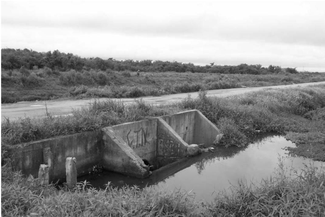
FIGURA 4.15 SIFÃO PARA COLETA DE ÁGUAS SUPERFICIAIS DO JARDIM GUARITUBA E TRANSPOSIÇÃO DAS MESMAS ATRAVÉS DO CANAL EXTRAVASOR
