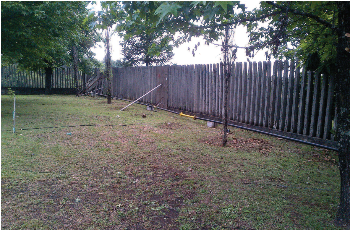
Figura 5.1 – Trecho da tubulação aérea, com destaque em amarelo do carretel de testes. (fonte: O Autor, 2015).
