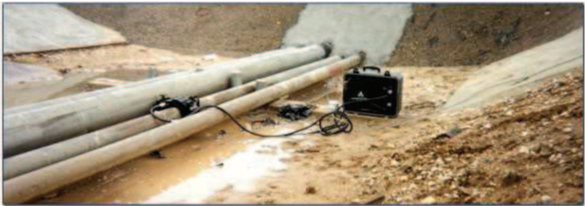
Figura 2.8 – Equipamento de ondas guiadas (fonte: PASA, 2015).
