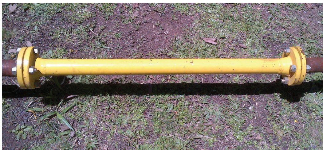
Figura 5.3 – Detalhe da fixação das amostras de tubos (fonte: O Autor, 2015).
