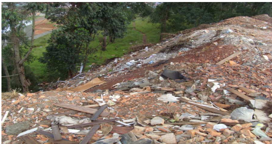
Figura 26- Aterro alto com mistura de materiais sem compactação
