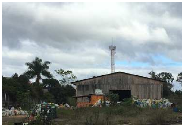
Figura 45 – Exterior e interior do barracão da Acamaro
