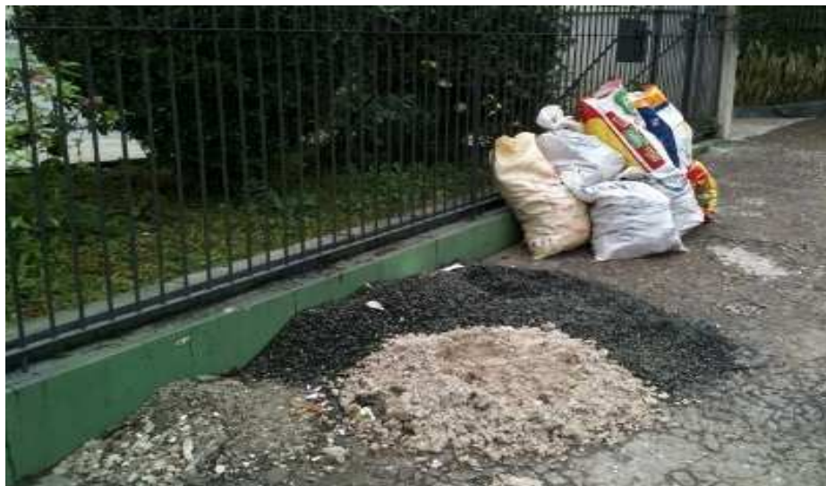
Figura 42 – RCD acondicionado em sacos para transporte junto ao lixo comum
