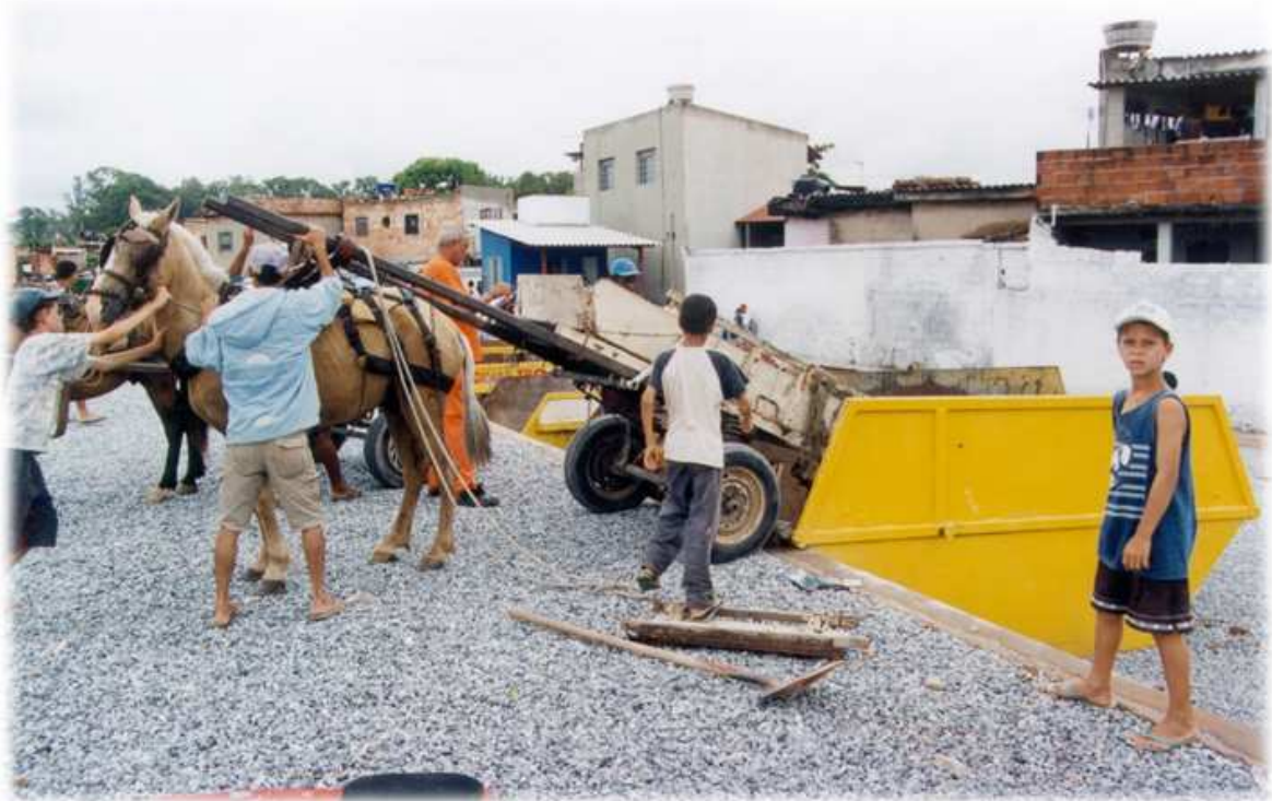
Figura 14 - Carroceiro descarregando RCD na caçamba Brooks
