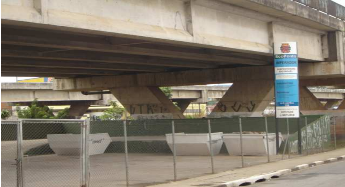
Figura 36- EcoPonto Imperador - São Paulo
