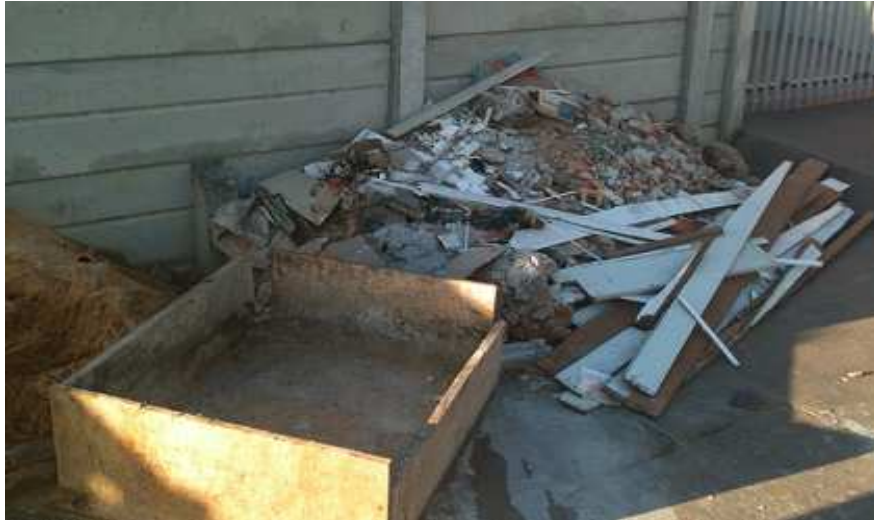
Figura 41 – Mistura de classes A e B no RCD a espera de destinação na calçada
