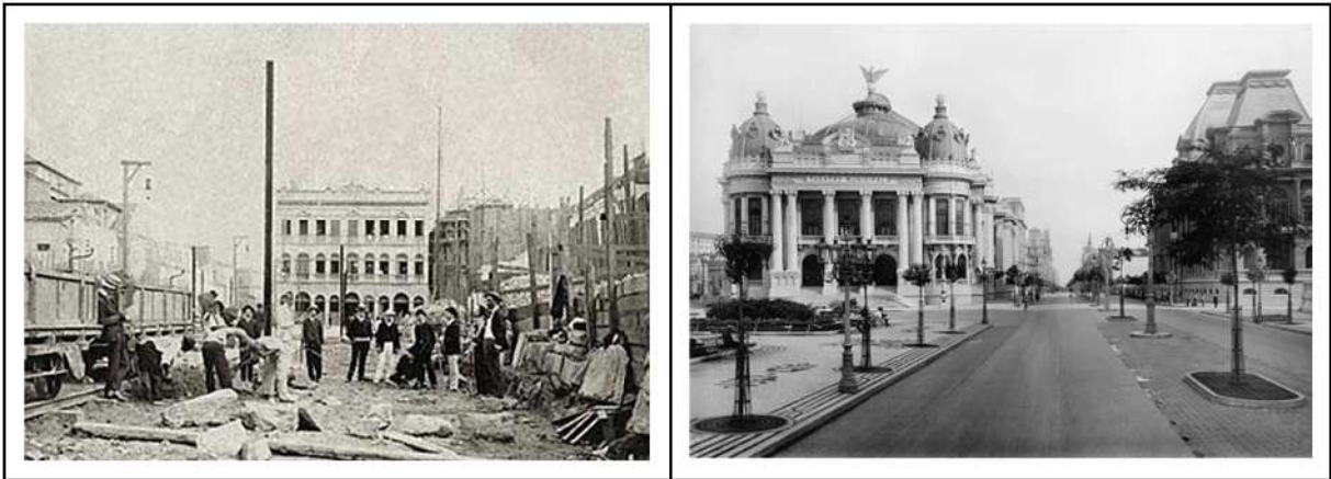
Figura 8 – Vistas de intervenções urbanas promovidas por Pereira Passos no Rio de Janeiro
