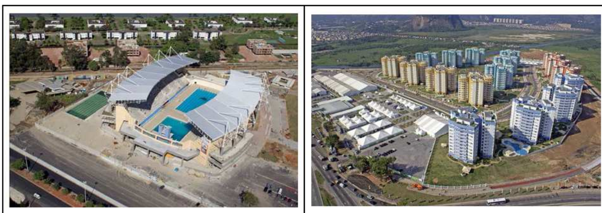
Figura 42 – Vistas do Parque Aquático Maria Lenk e de edifícios da vila pan-americana na Área da Barra da Tijuca
