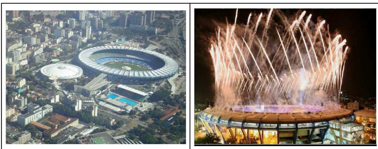
Figura 45 – Vistas de instalações na Área do Maracanã
