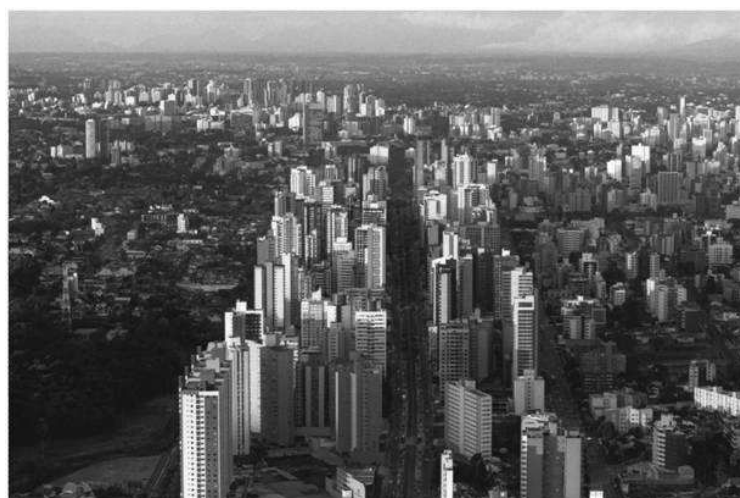
Figura 9 – Vista aérea do adensamento previsto no Plano Diretor de Curitiba consolidado no Setor Estrutural Sul e Zonas adjacentes Fonte: IPPUC
