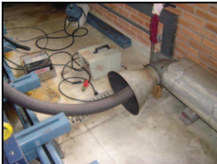
Figura 28 – Sistema de exaustão para o escapamento.
