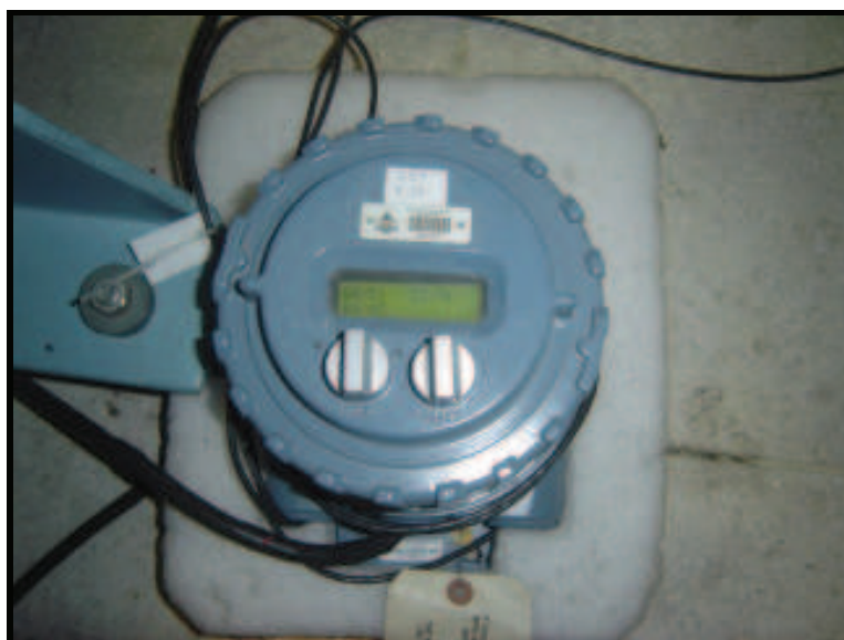
Figura 27 – Visor digital do medidor de fluxo Coriolis.
