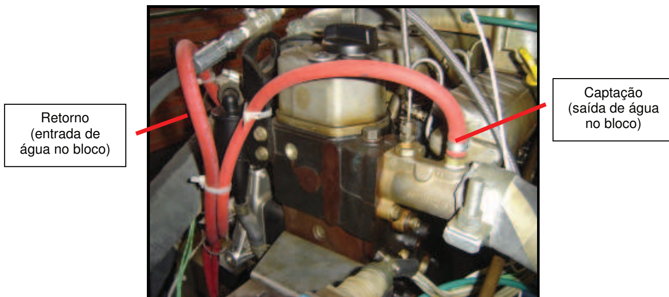
Figura 06 – Arrefecimento da reguladora de pressão de GNV.
