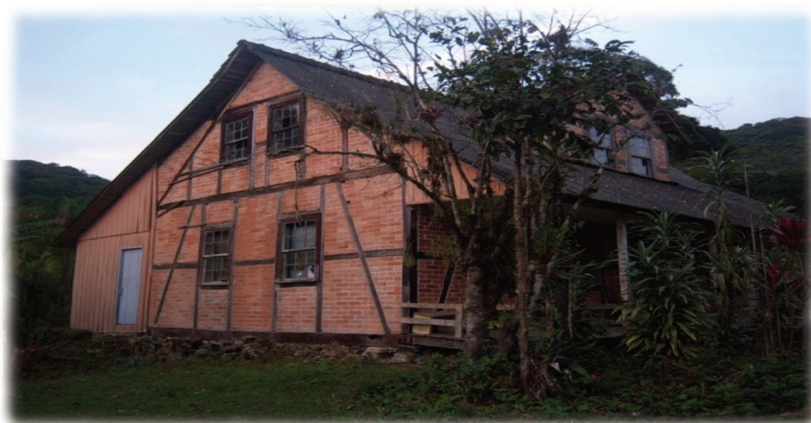
Figura 07 - Foto atual do edifício onde funcionou o 1º internato adventista, em Gaspar Alto, SC.
