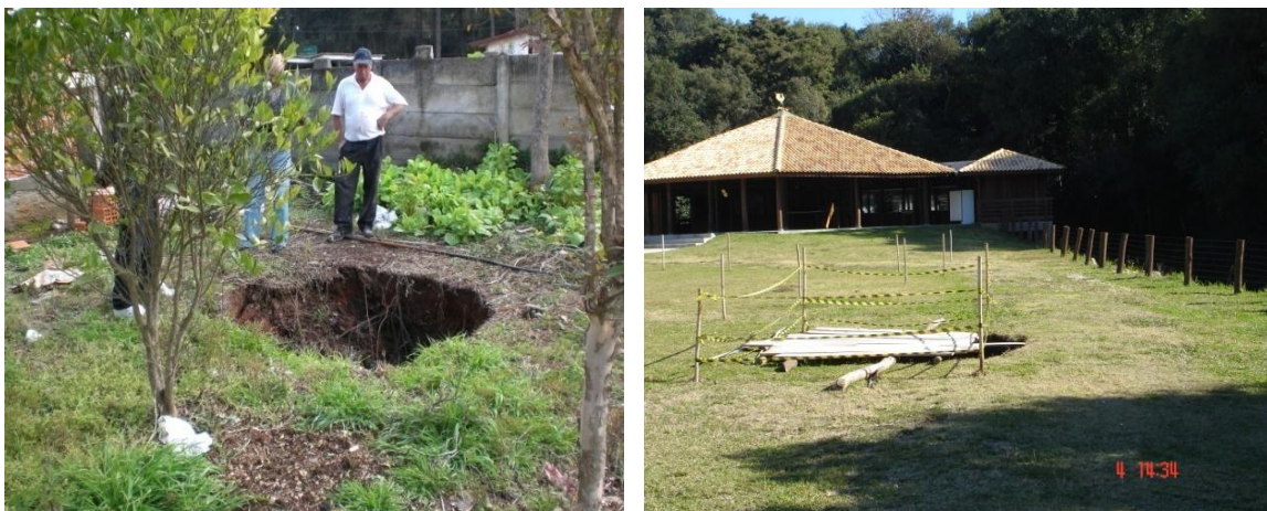
FIGURAS 2.6 E 2.7 – COLAPSO NATURAL DE SOLO (DOLINA) EM ÁREA CÂRSTICA DE ALMIRANTE TAMANDARÉ
