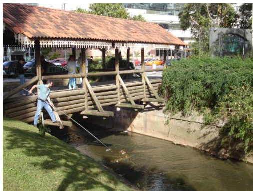
RB8 – montante da canalização
