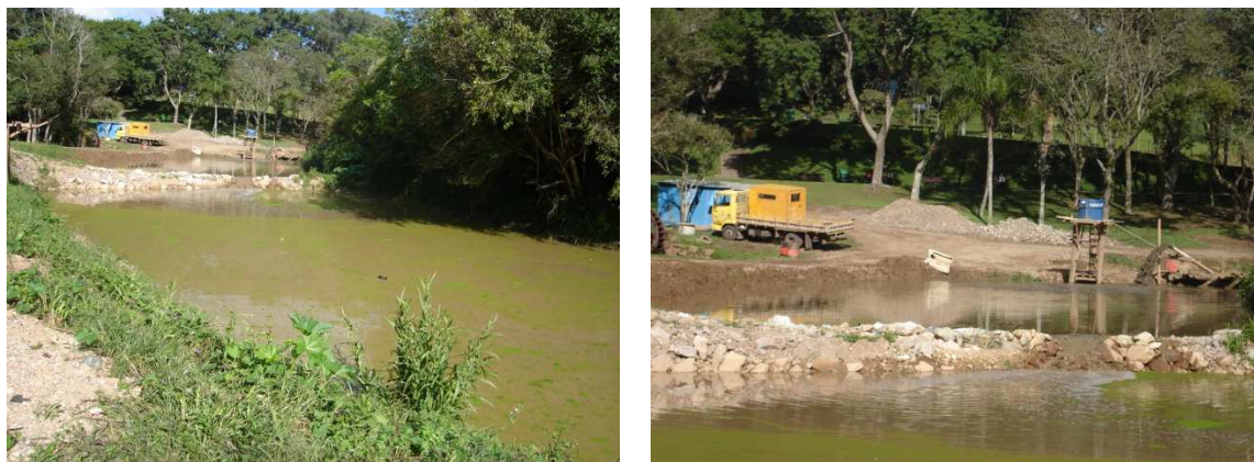
Figura 49. Dragagem na lagoa do Parque São Lourenço.
