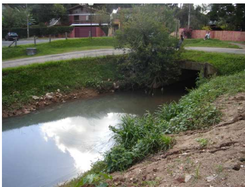
RB6 – montante São Lourenço
