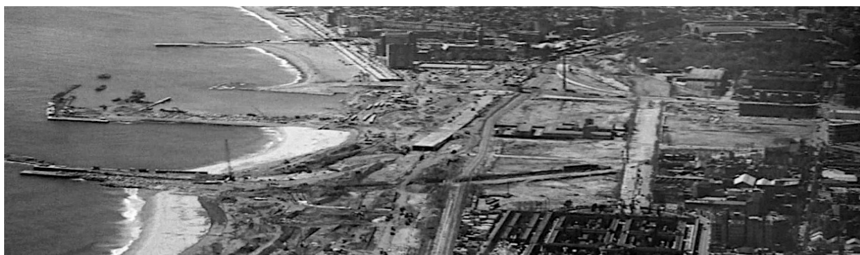
Figura 24 - Construção da Villa Olímpica dos Jogos de 1992, Barcelona, Espanha
