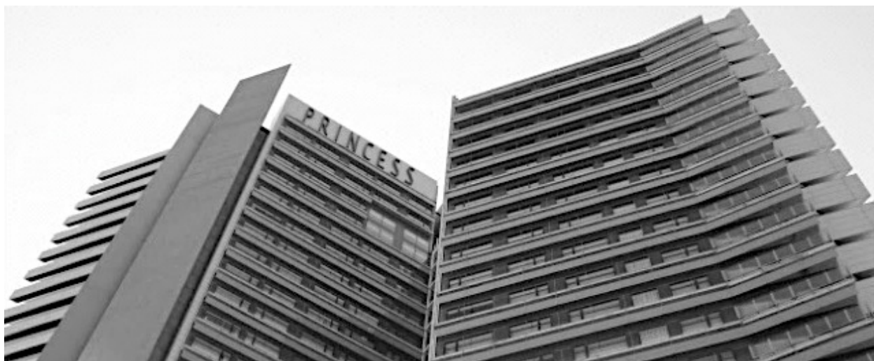
Figura 28 - Princess Hotel, Barcelona, Espanha
