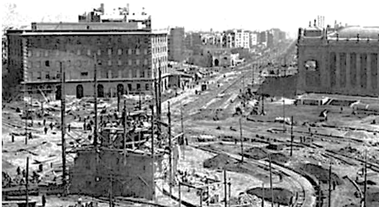
Figura 42 - Revitalização Avenida Reina Marina e Plaza Espanya, Barcelona, Espanha
