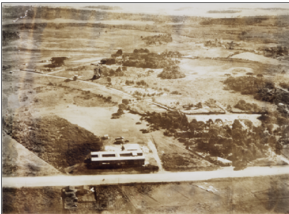
Figura 5 – Construção do Ginásio Estadual Romário Martins – 1966 Fonte: Secretaria Municipal de Cultura e Esporte de Piraquara
