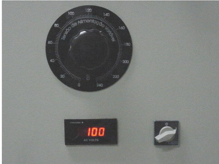
Figura 2.11. Controle de tensão do VARIAC mostrando ajuste para 100V.
