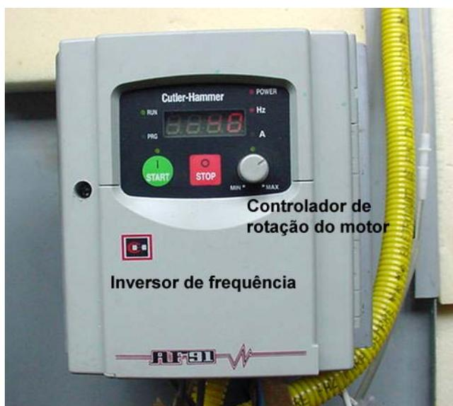
Figura 3.21 - Inversor de Frequência.
