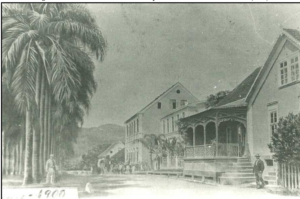
Figura 13 - Nova Escola Alemã com dois pavimentos na Rua das Palmeiras (1900)
