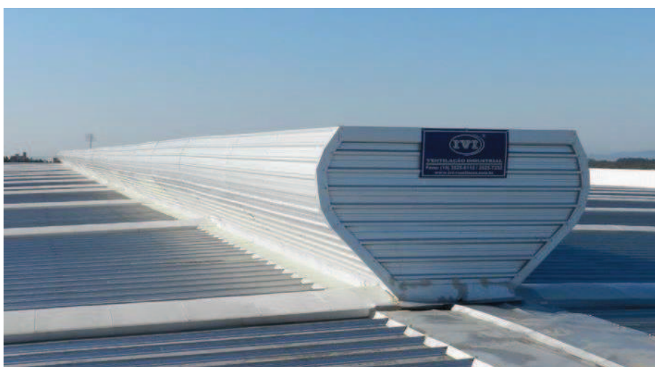
Figura 73 – Lanternim do tipo “fluxo ascendente”.
