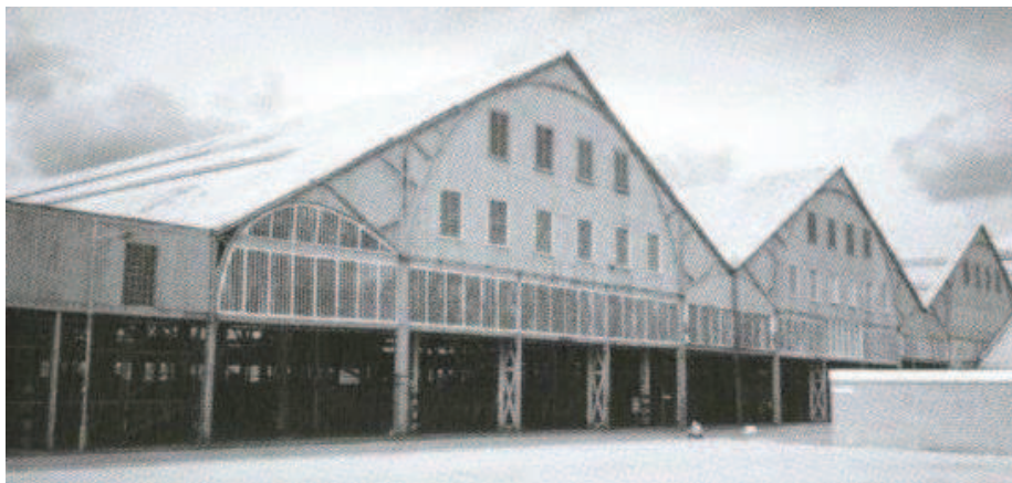
Figura 7 – Rampa coberta N° 4, Chatham Historic Dockyard , Kent, Inglaterra.
