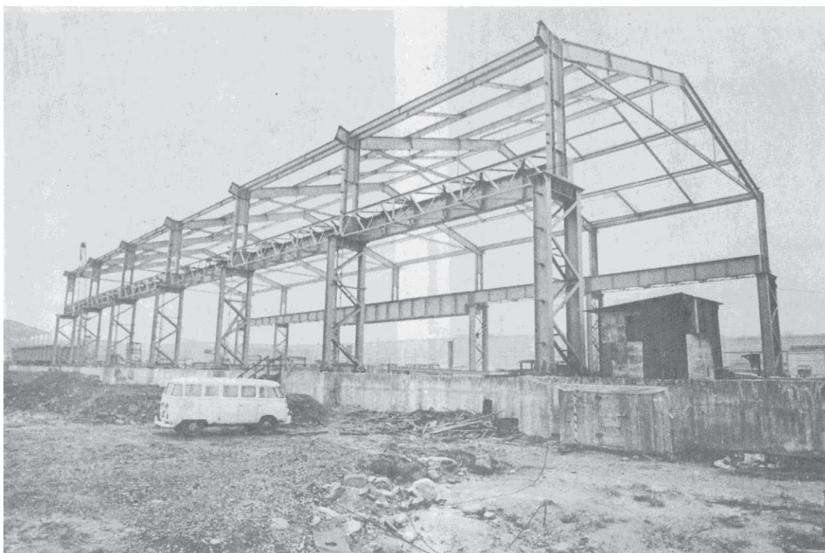
Figura 17 – Edifício industrial da década de 1970 em fase de montagem.
