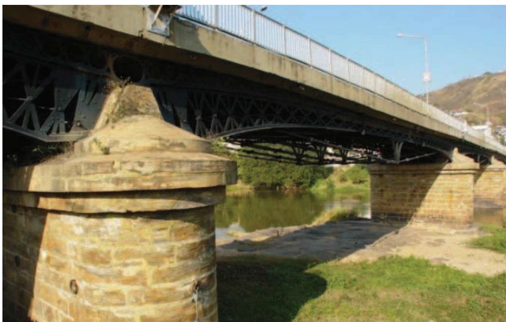
Figura 10 – Ponte de Paraíba do Sul, localizada no centro urbano do município de Paraíba do Sul, RJ.
