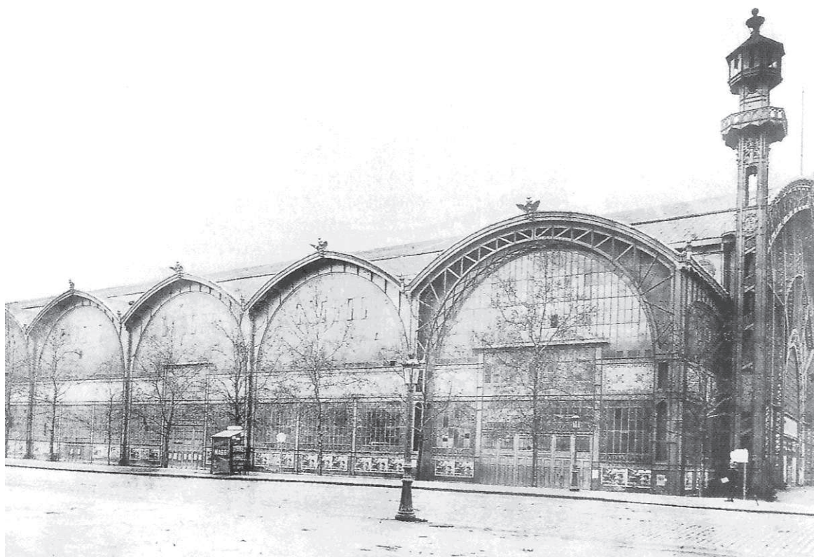
Figura 13 – Galérie des Machines , Exposição Universal, Paris, 1887-89. Engeheiro: Victor Contamin; arquiteto: Ferdinand Dutert.
