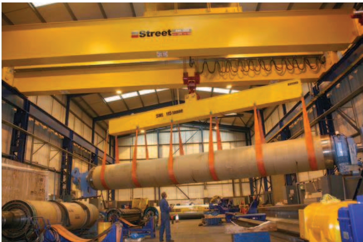
Figura 1 – Ponte rolante dupla viga em um edifício industrial construído com estrutura de aço.
