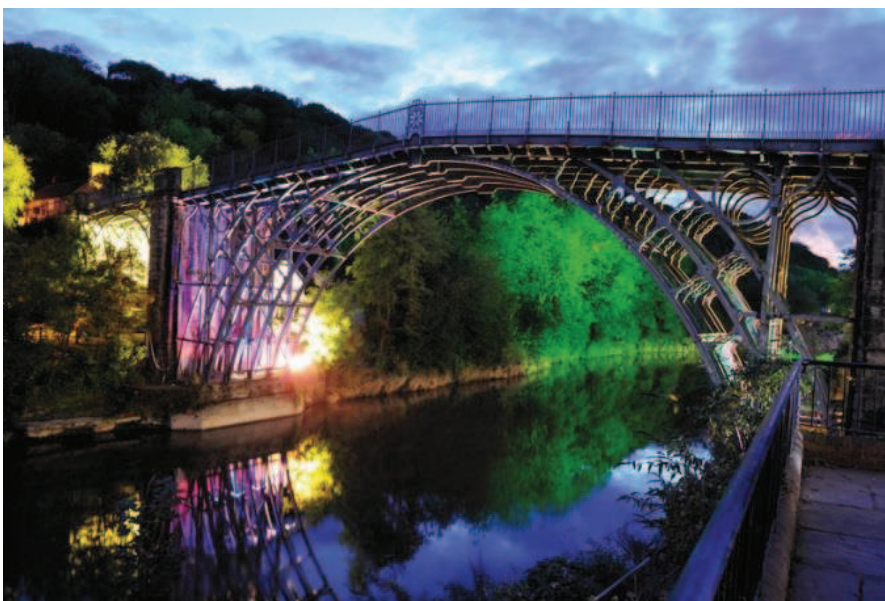
Figura 9 – Iron Bridge sobre o Rio Severn , Shropshire, Inglaterra, concluída em 1779.
