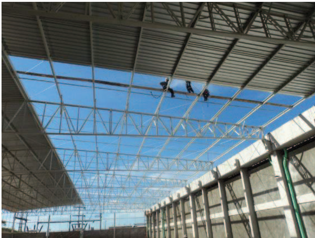
Figura 39 – Edifício estruturado em aço https://www.youtube.com/watch?v=yFQnA8LAVXU o durante a montagem das telhas.
