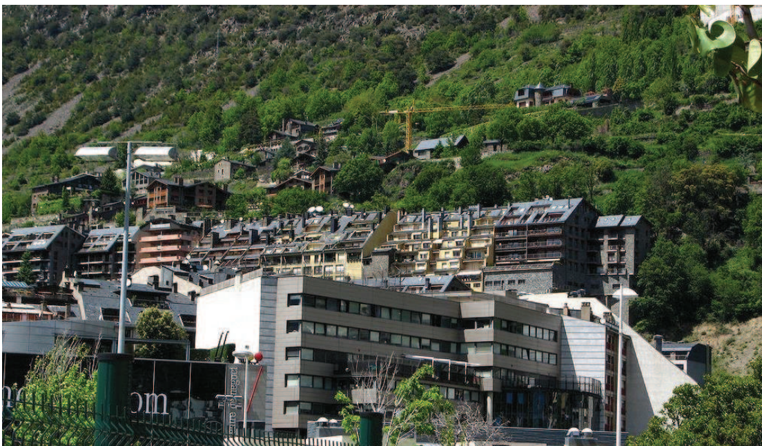
Figura 25 – Habitações em um vilarejo nos Pirineus, na Espanha, na cordilheira que faz divisa natural com a França. Um exemplo de perfil topográfico constituído por morro.
