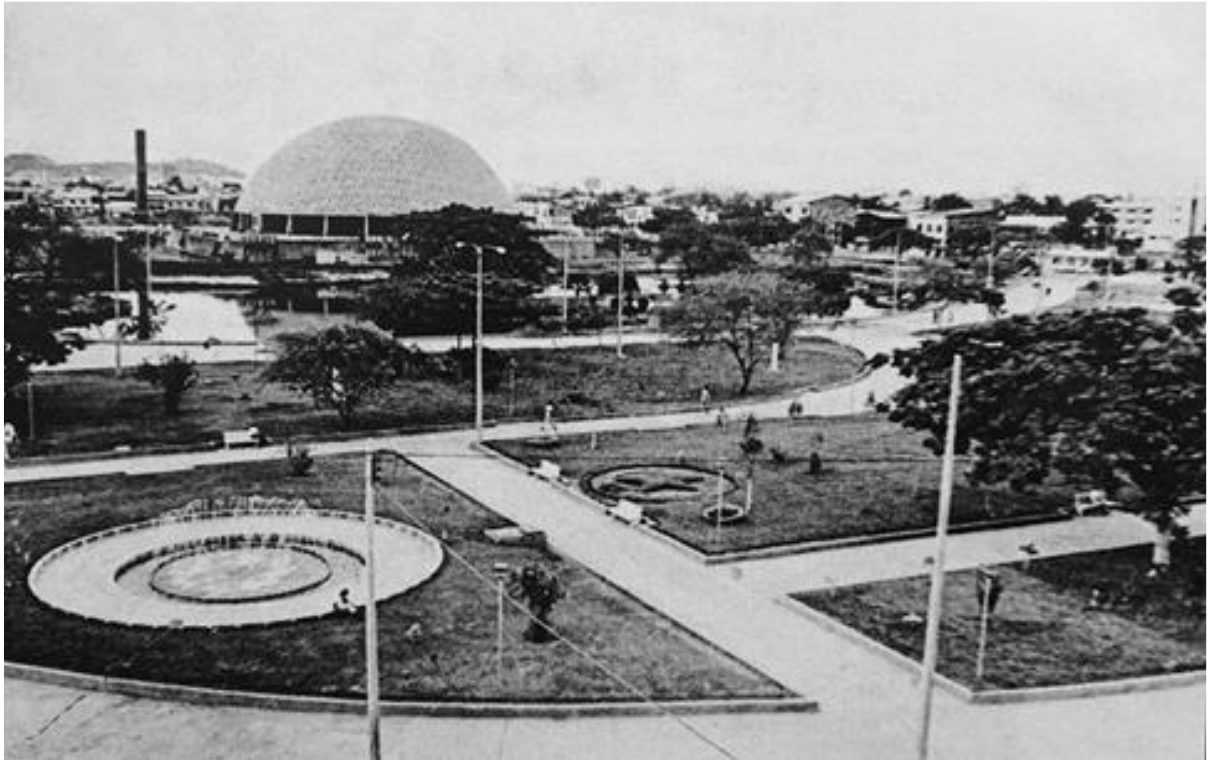
Figura 43 - Parque Forestal con el Teatro Centro Cívico al sur de Guayaquil en los años de 1970 en terrenos municipales donde estuvo el antiguo hipódromo Jockey Club. Fuente: Guayaquil 2020.
