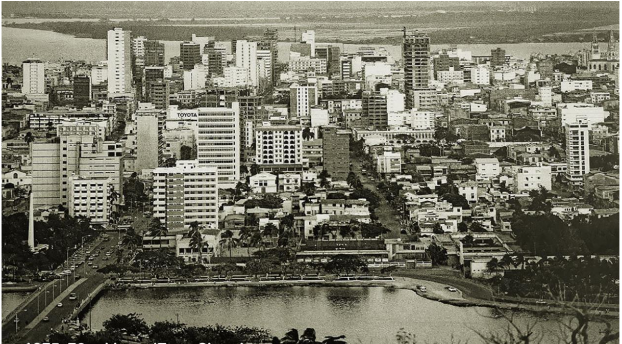
Figura 74 - Vista panorámica del puente 5 de junio sobre el estero Salado junto al Malecón del Salado en Guayaquil durante la década de 1970.
