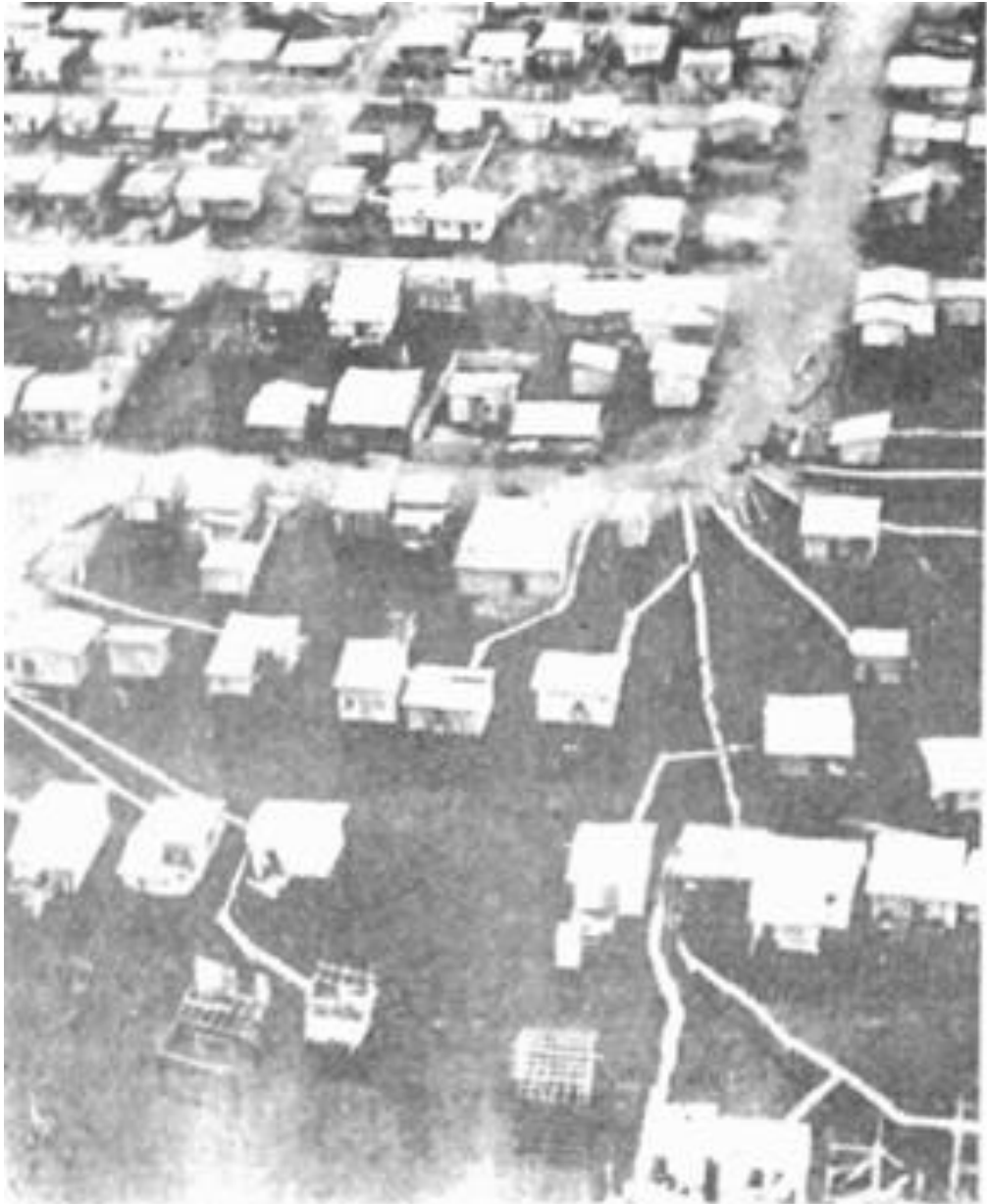
Figura 48 - Crecimiento asentamientos sobre pantanos en el Guasmo Sur. En primer plano casas sobre pilotes y en el segundo, casas sobre rellenos.
