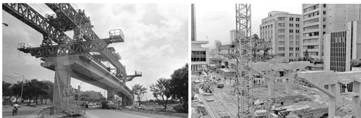
Figura 59 - Imágenes de la construcción del metro de Medellín en los años 1983 y 1988. Fuente: concejodemedellín.gov.co; Colombia.com.
