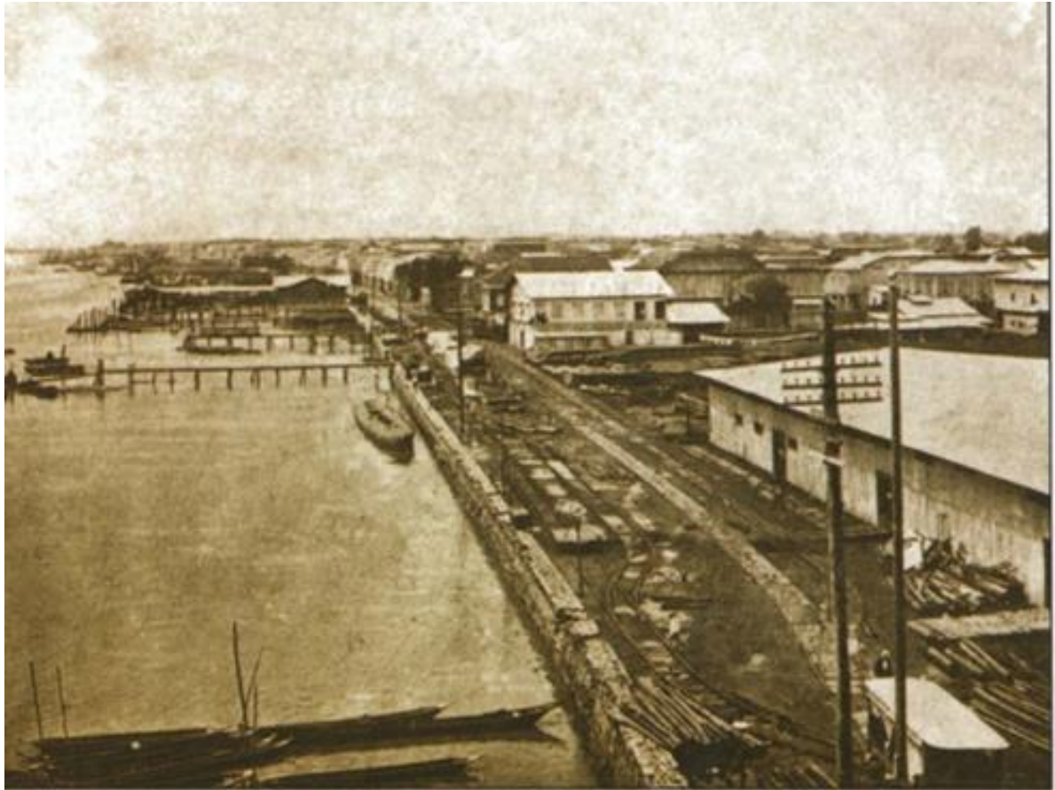
Figura 3 - Vista norte-sur del malecón teniendo a la derecha y en primer plano las bodegas de la Aduana en 1905. Fuente: Guayaquil antes y después del Gran Incendio, 2004.
