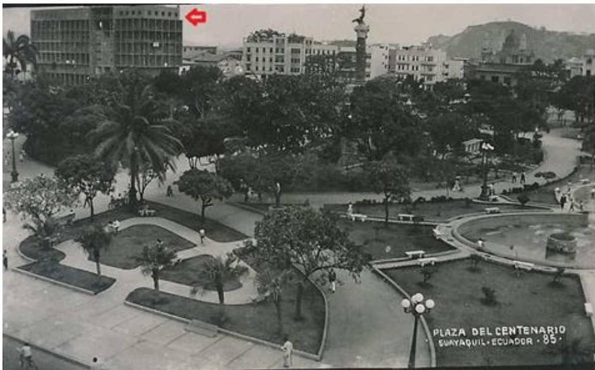
Figura 40 - Proyecto de La Casa de la Cultura- Núcleo del Guayas en proceso de construcción frente a la plaza del Centenario.
