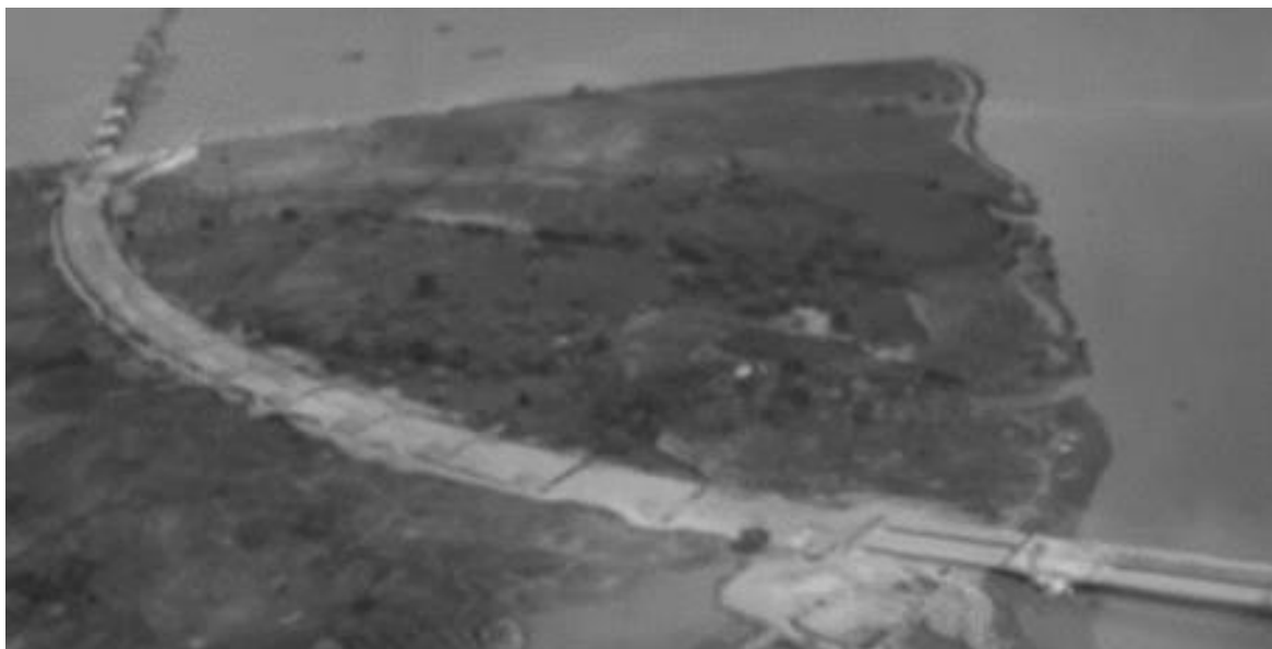
Figura 54 - Sector de la futura urbanización La Puntilla entre los dos tramos del Puente de la Unidad Nacional. Fuente: Documental Cofit Consorcio de Firmas Italianas para la construcción del puente río Guayas.
