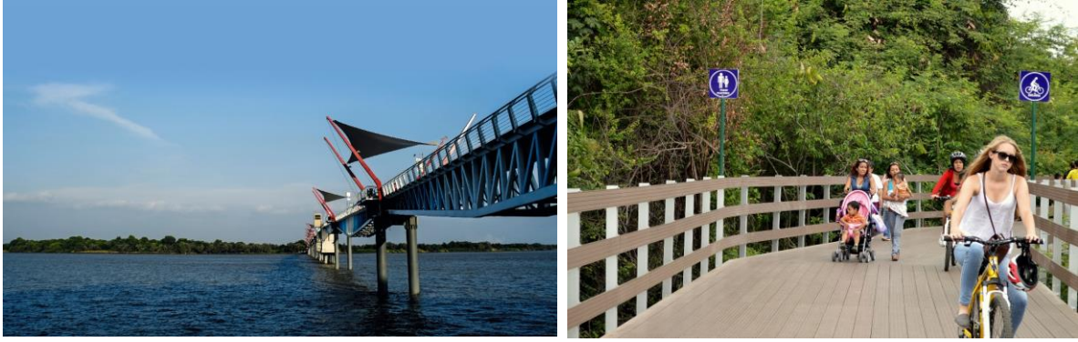
Figura 90 - (Izq.) Puente basculante para peatones y ciclistas entre Guayaquil y la Isla Santay. (Der.) Sendero que comunica hasta la ecoaldea al interior de la Isla Santay. Fuente: Ricardo Bohorquez; Ecuador travel Pinterest.com.
