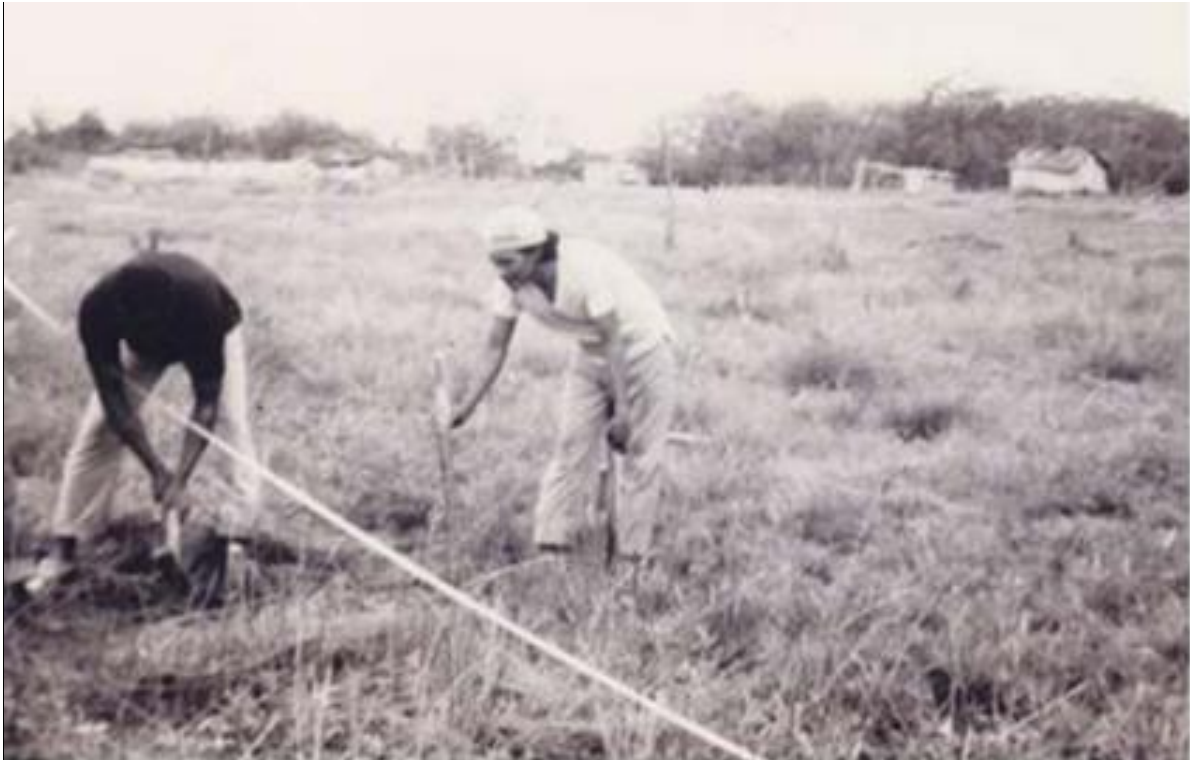
Figura 49 - Medición de solares en le ex hacienda El Guasmo para que moradores en sus terrenos puedan construir casas.
