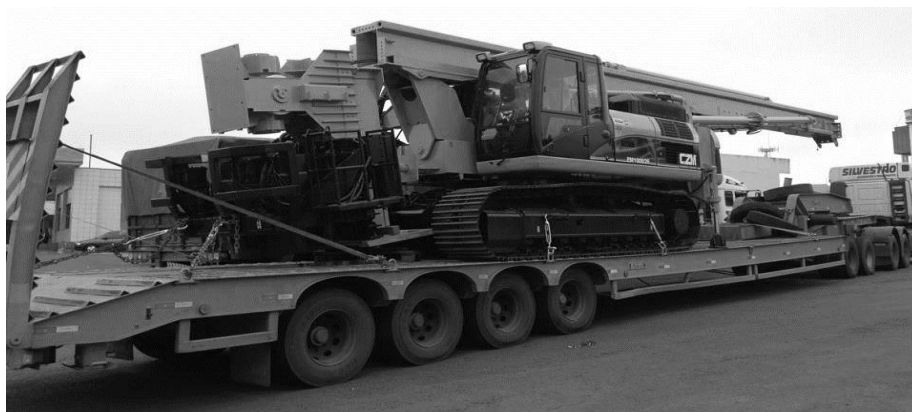
Figura 12 - Transporte da máquina hélice contínua
