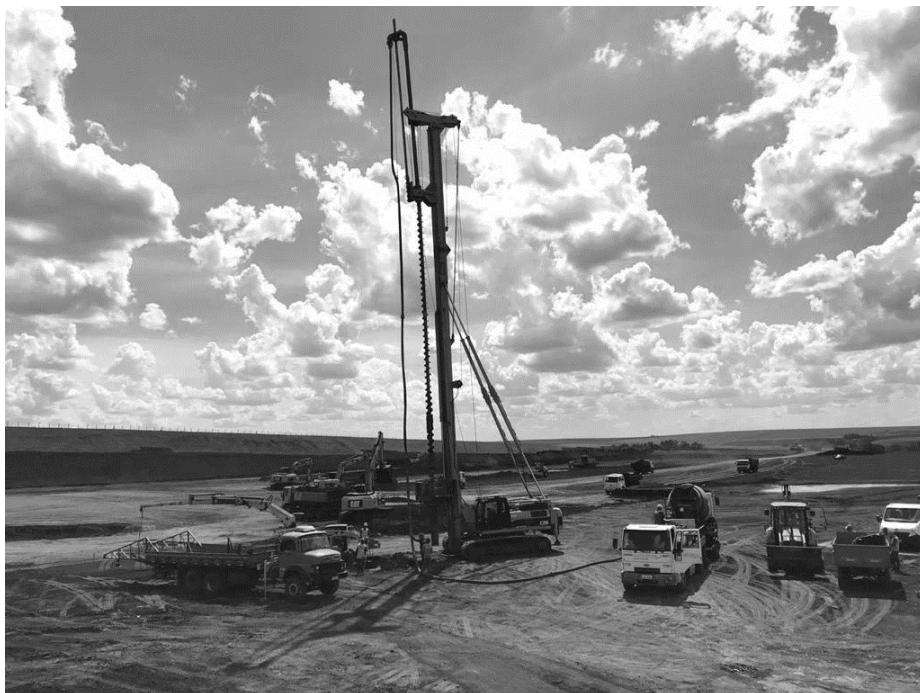
Figura 14 - Obras no centro de distribuição de uma cooperativa agroindustrial
