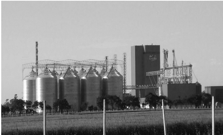
Figura 13 - Silos de armazenagem de grãos
