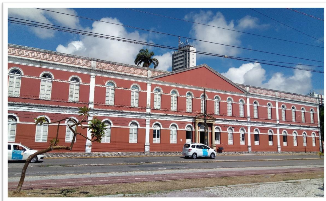
FIGURA 2 – Vista frontal do Ginásio Pernambucano na rua da Aurora (2018)
