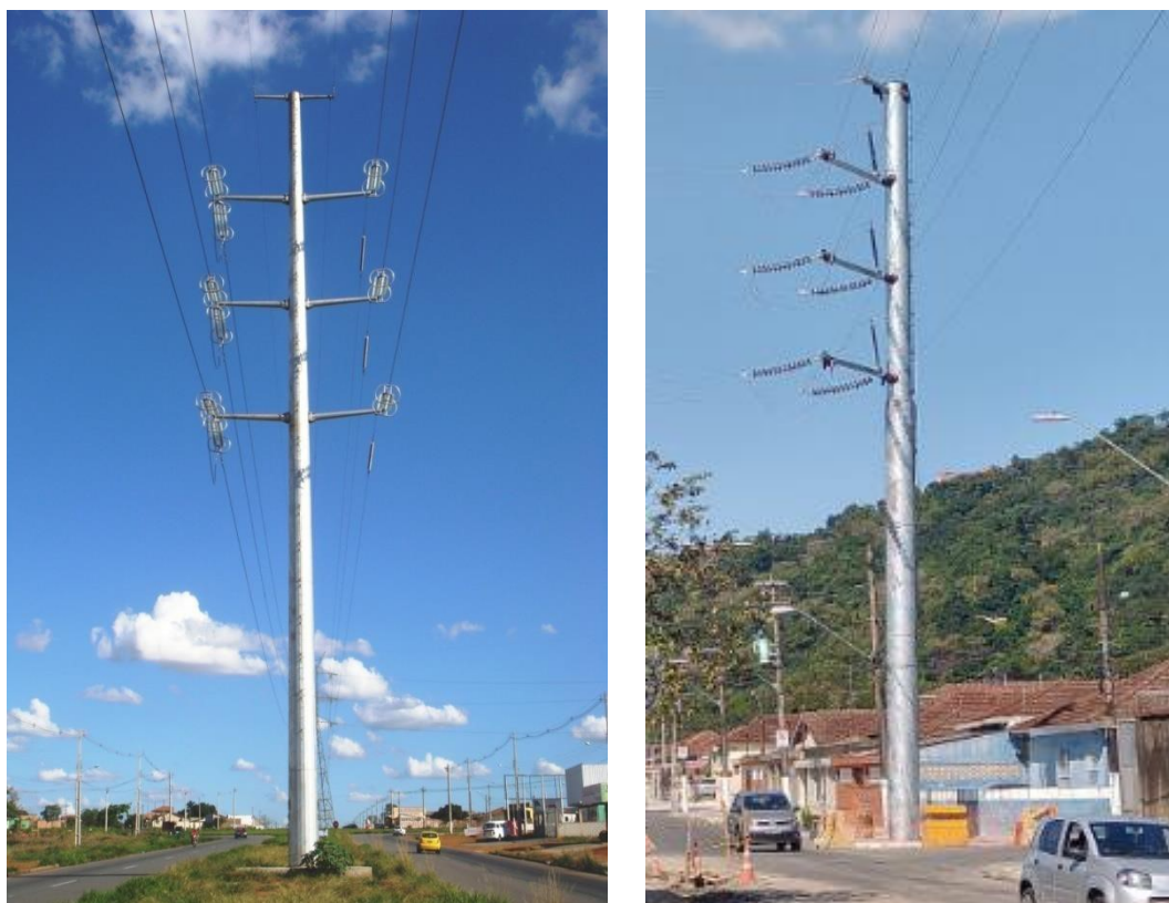
Figura 1.1: Aplicação de torres monotubulares em linhas de transmissão.
