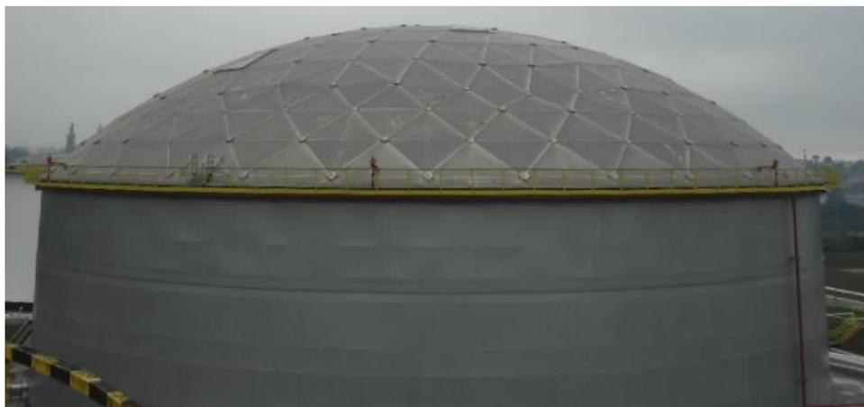
Figura 48: Domo geodésico utilizado para cobrir um tanque de combustível de 24m de diâmetro.
