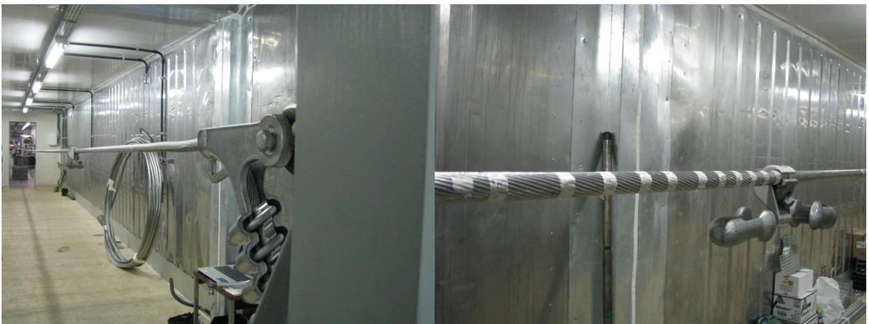
Figura 4.6: Posicionamento do amortecedor conforme comprimento *Pos* na Tabela 4.
