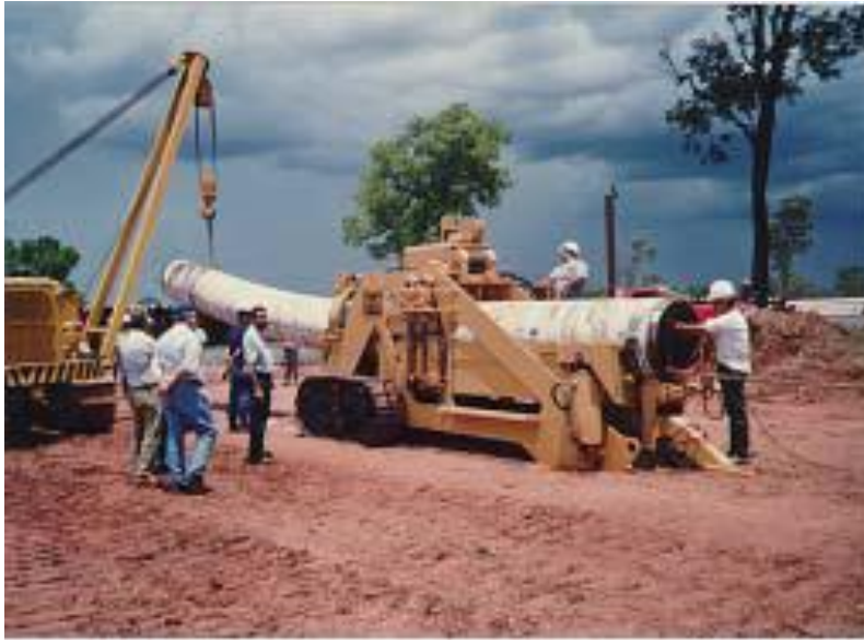
Figura 8 – Processo de calandragem (Pereira et al., 2007)
