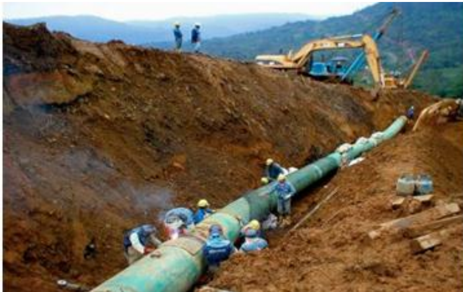
Figura 7 – Instalação de um duto de petróleo.
