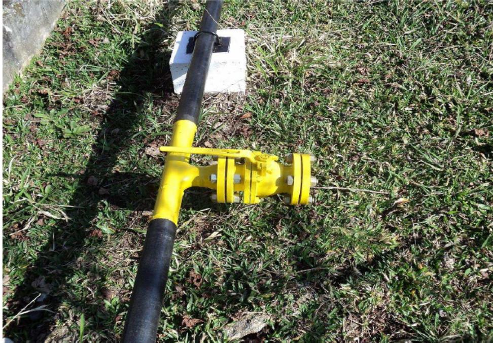
Figura 6.1 - Detalhe de válvula de bloqueio ao longo do trecho de tubulação.
