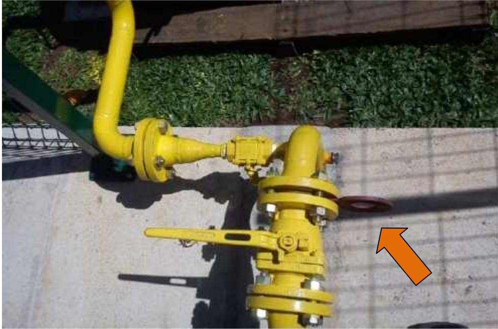
Figura 6.27 - Detalhe da alimentação do ramal experimental a partir do ramal externo de gás natural, indicando a “figura oito” utilizada.
