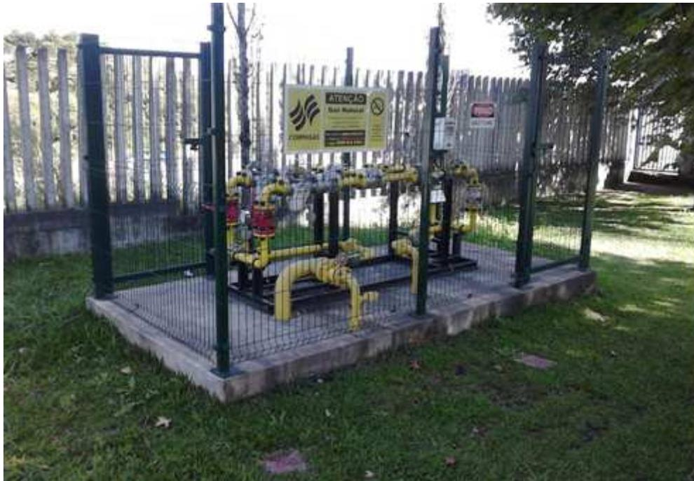
Figura 6.7 – Estação de medição da **COMPAGAS**.
