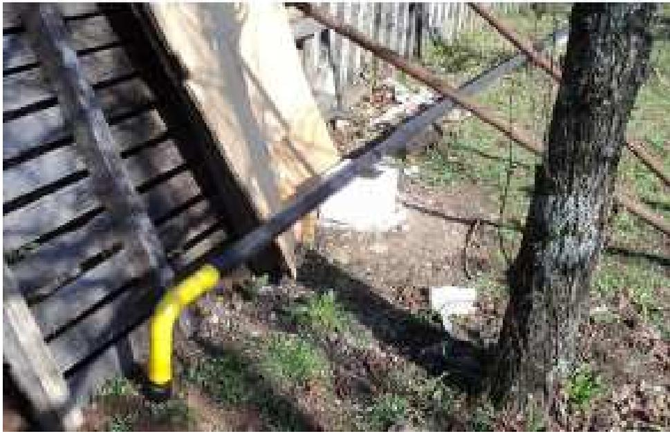
Figura 6.3 - Transição entre os trechos de tubulação aéreo e enterrado.
