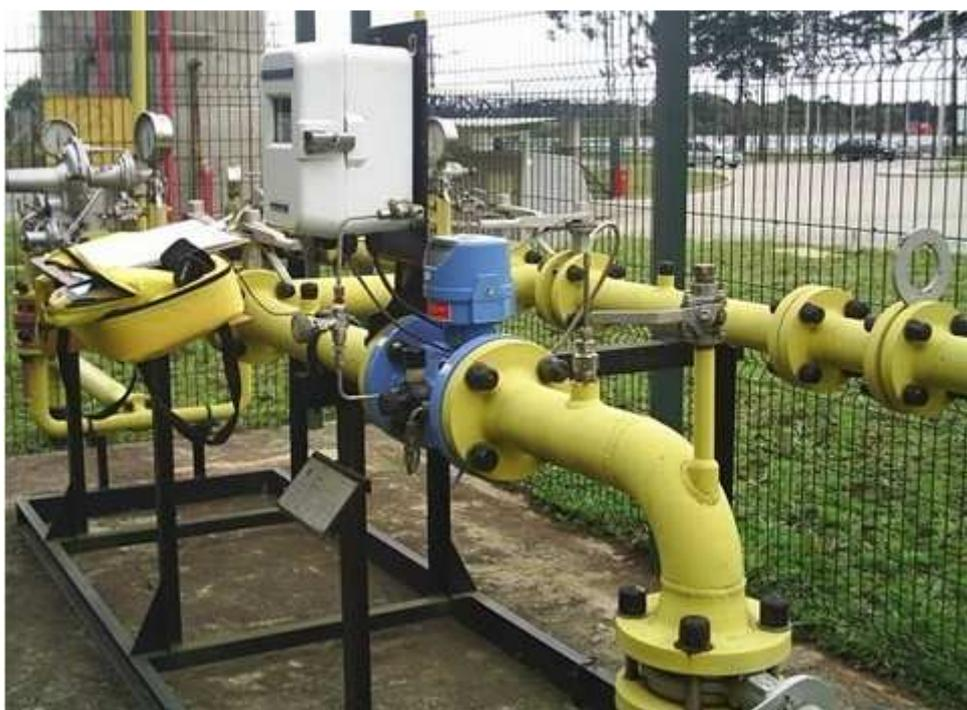
Figura 3.4 – Estação de medição e redução de pressão – **COMPAGAS**,
