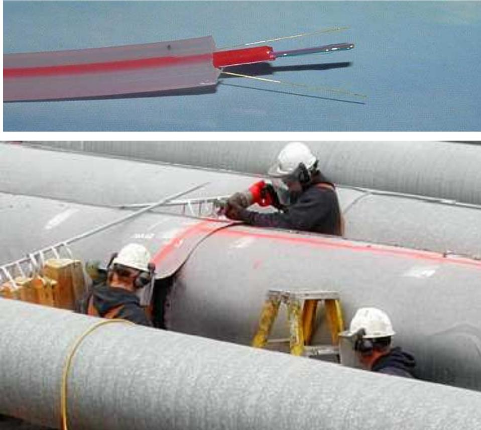
Figura 2.8 – Exemplo de cabo sensor de temperatura e sua respectiva instalação sobre a tubulação, ([www.flowtec-brasil.com.br](http://www.flowtec-brasil.com.br)).
