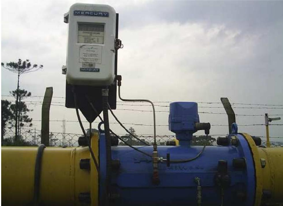
Figura 3.5 – Eletrocorretor padrão – **COMPAGAS**, (Almeida et al., 2013).
