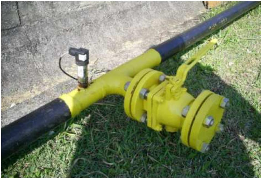
Figura 6.9 – Detalhe da instalação do sensor de pressão junto a uma das válvulas de bloqueio do ramal experimental.
