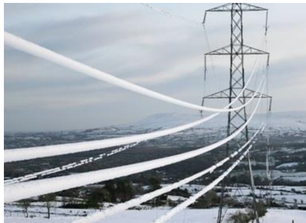
Figura 5 - Cabos elétricos com gelo acumulado. Fonte: BBC News, 2011.
