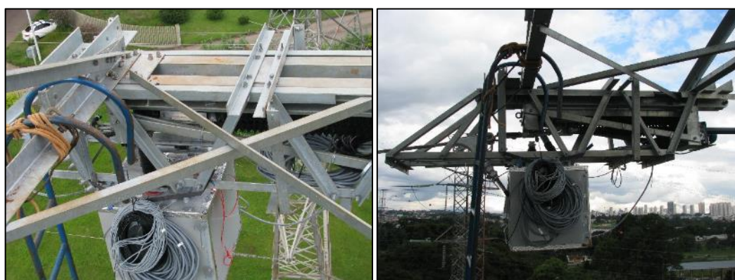
Figura 13 - Instalação dos vibradores nas três fases da LTE Fonte: O autor.
