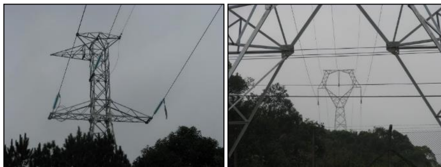
Figura 54. Estrutura de número três pós-lançamento de cabos (à esquerda) e o vão experimental formado pelas torres 1 e 2 Fonte: O autor.
