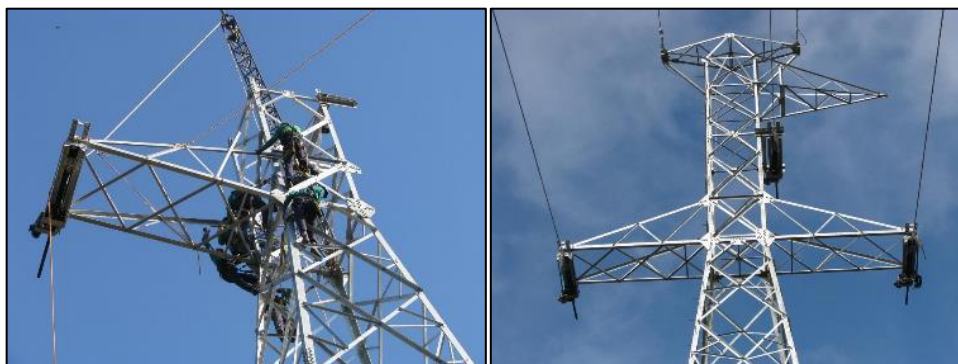
Figura 19 –Fixação do sistema de tração nas mísulas (braços da torre)
