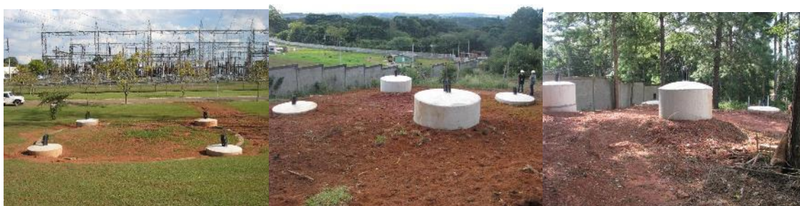
Figura 52. – Fundações das torres 1 a 3 concretada com as ferragens afloradas acima do concreto Fonte: O autor.
