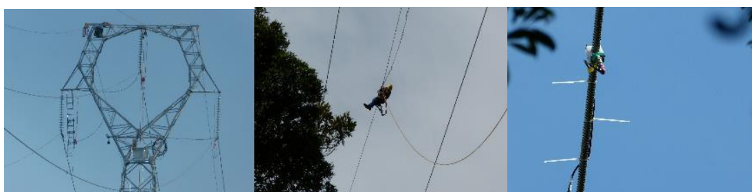
Figura 23. Instalação dos acelerômetros nos cabos condutores Fonte: O autor.
