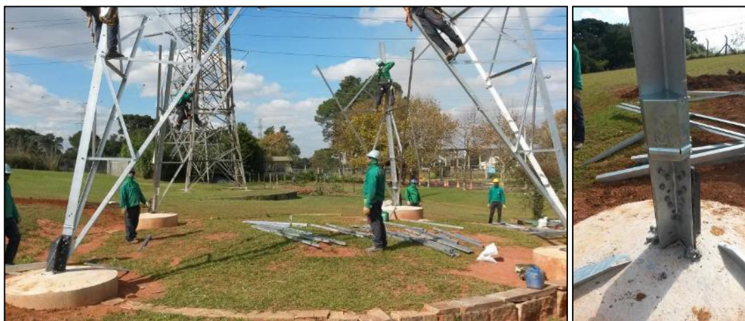
Figura 73 - montagem da torre instrumentada com detalhe do montante instrumentado Fonte: O autor.
