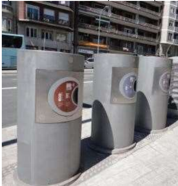
Figura 8. Coletores superficiais da coleta seletiva “pneumática” para residências e comércio
