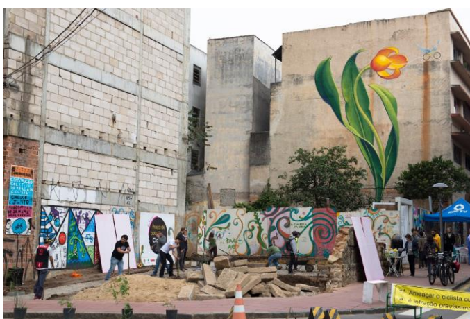
Figura 49 - Terreno da Praça de Bolso do Ciclista em reforma
