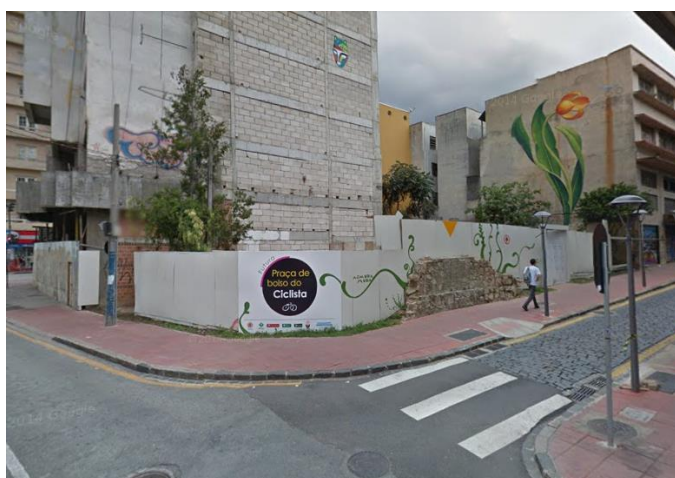
Figura 48 - Terreno da Praça de Bolso do Ciclista em reforma
