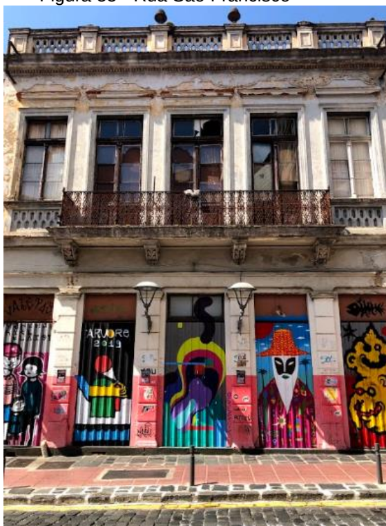
Figura 55 - Rua São Francisco
