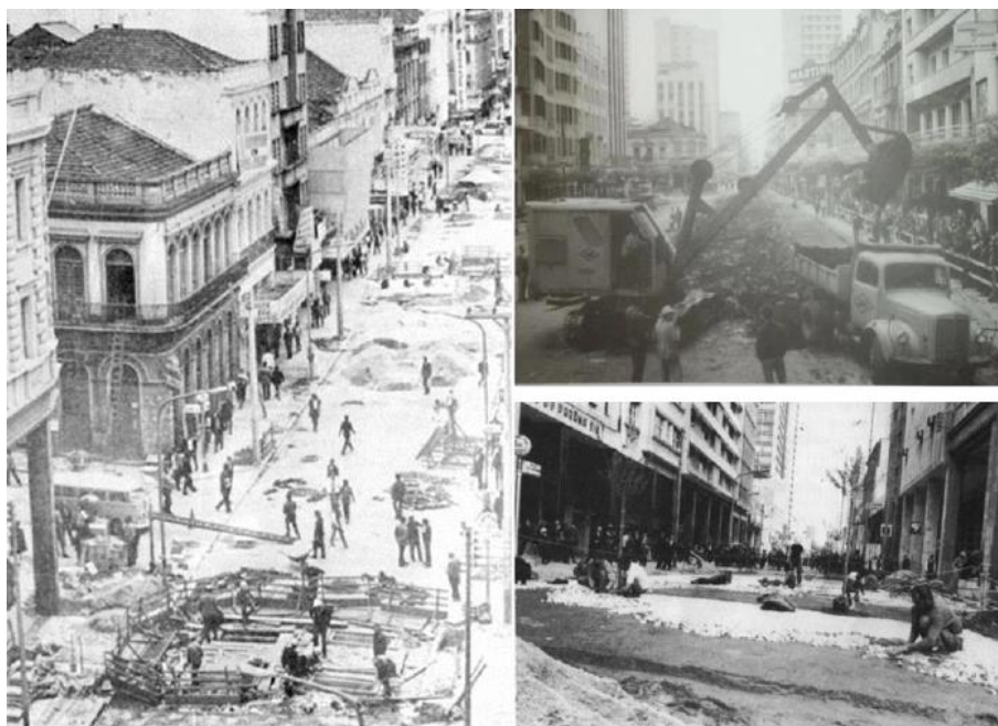
Figura 28 - Obras de calçamento da Rua XV de Novembro em 1972
