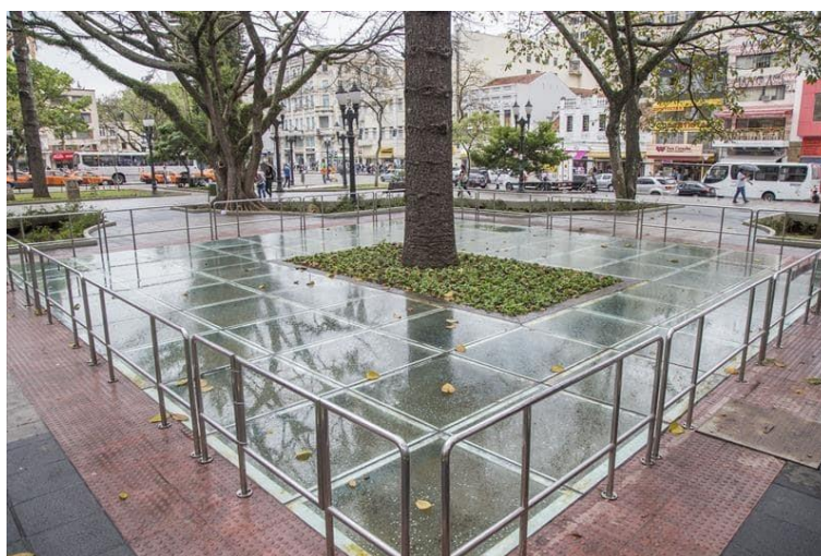
Figura 10 - Piso de vidro mostrando calçamento original
