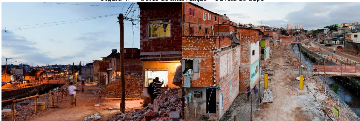
Figura 47 – Obras de intervenção – Favela do Sapé
