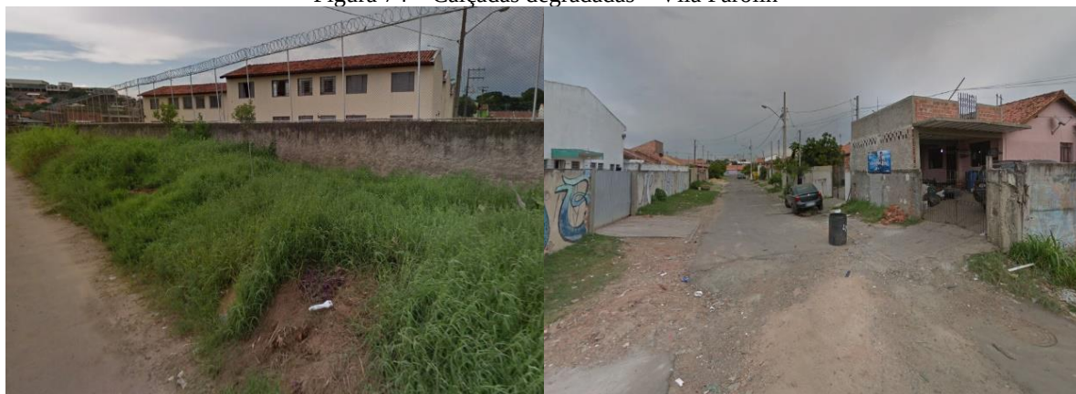
Figura 74 – Calçadas degradadas – Vila Parolin
