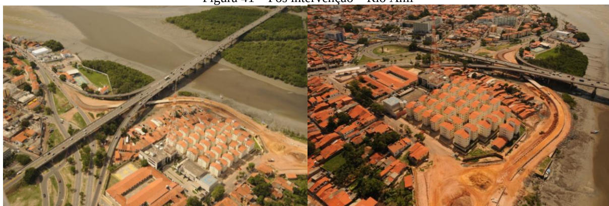
Figura 41 – Pós intervenção – Rio Anil
