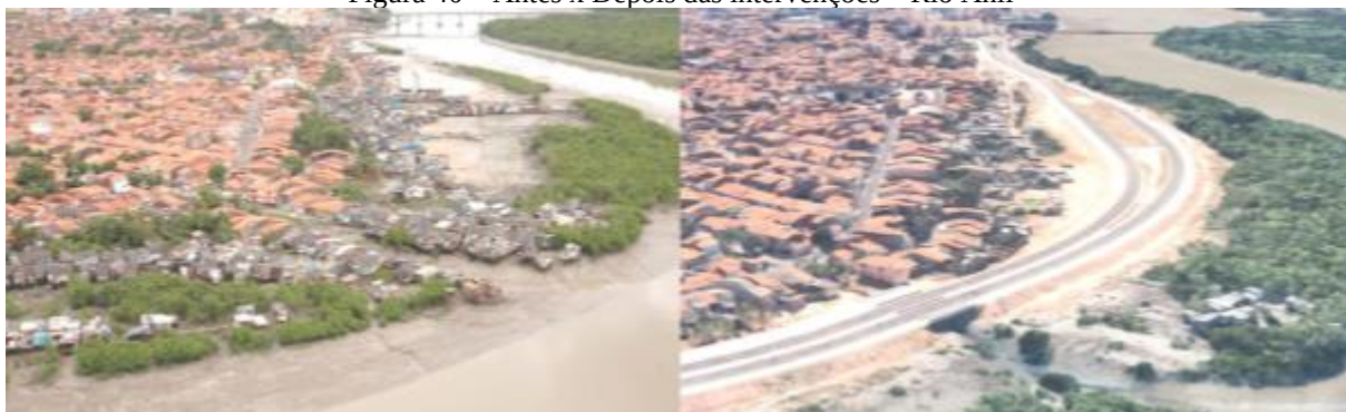
Figura 40 – Antes x Depois das intervenções – Rio Anil
