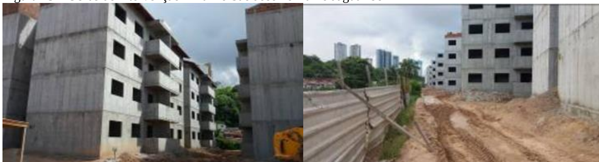
Figura 25 – Obras de intervenção – Bairro São José no Baixo Jaguaribe
