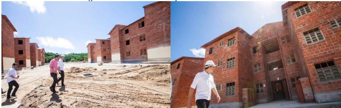
Figura 18 – Obras de intervenção – Comunidade do Dendê
