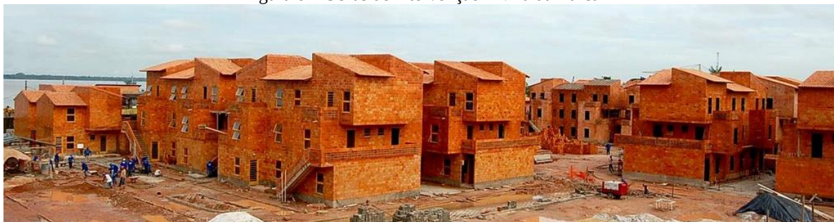
Figura 6 – Obras de intervenção – Vila da Barca
