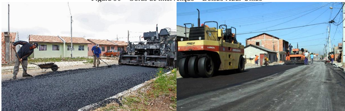
Figura 90 – Obras de intervenção – Bolsão Audi-União
