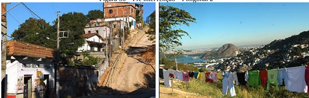
Figura 56 – Pré intervenção – Poligonal 2
