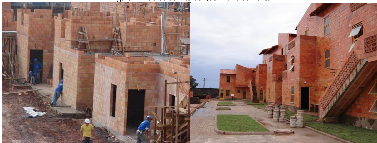
Figura 7 – Obras de intervenção – Vila da Barca
