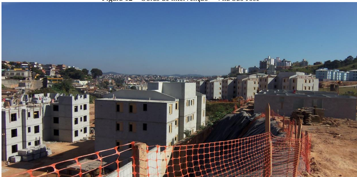
Figura 12 – Obras de intervenção – Vila São José
