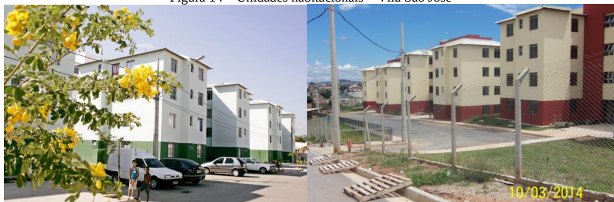
Figura 14 – Unidades habitacionais – Vila São José
