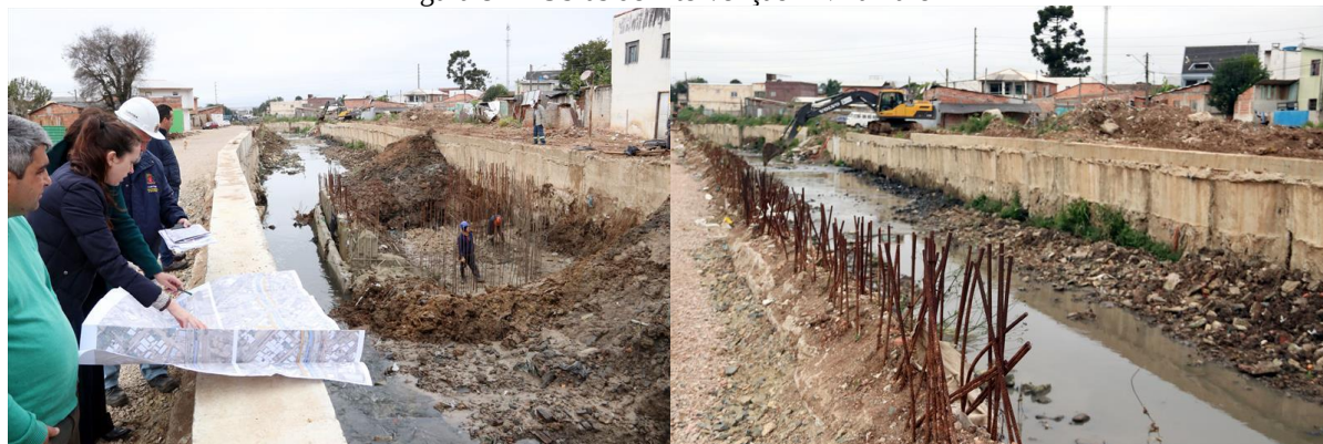
Figura 81 – Obras de intervenção – Vila Parolin
