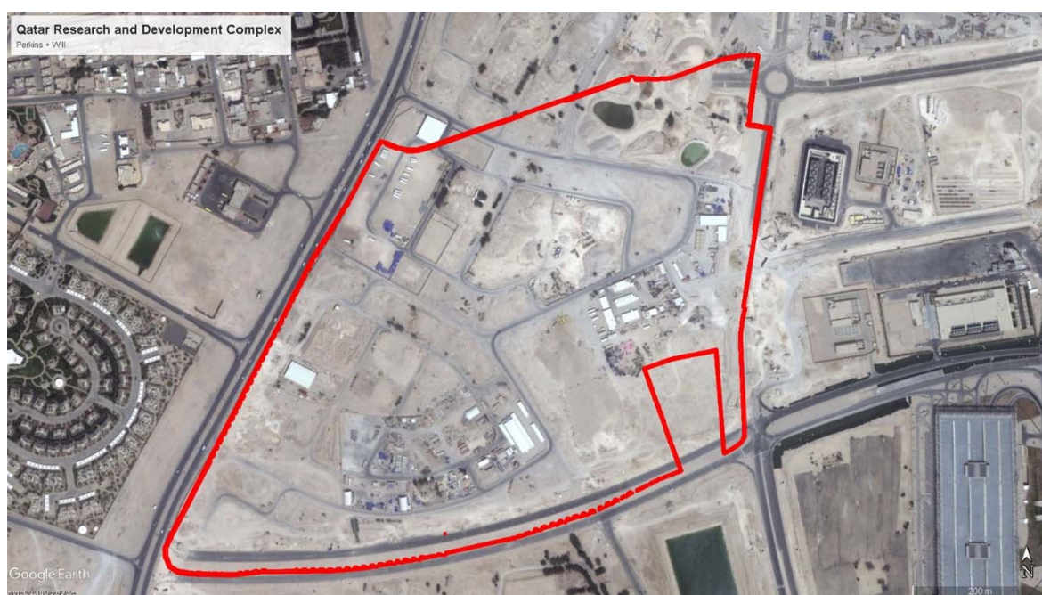
Figura 88: Imagem aérea do sítio do projeto QATAR RESEARCH AND DEVELOPMENT COMPLEX
