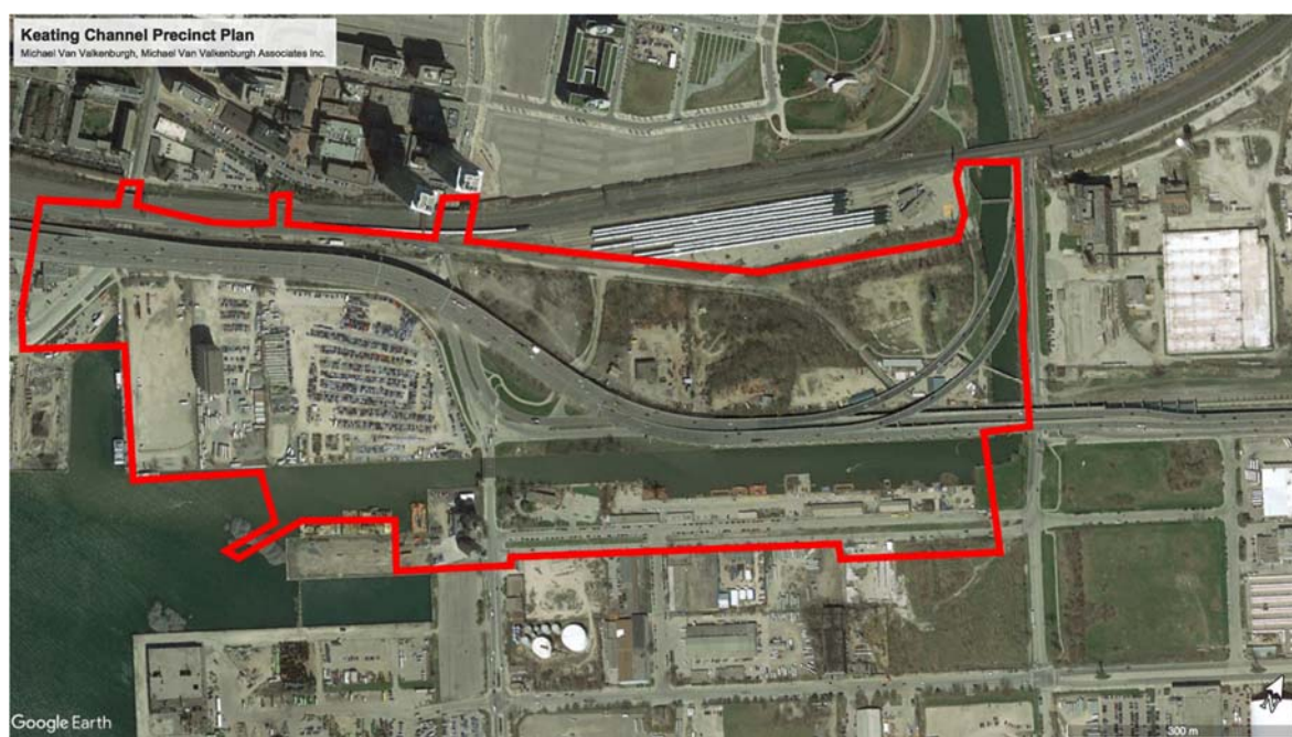
Figura 192: Imagem aérea do sítio do projeto KEATING CHANNEL PRECINCT
