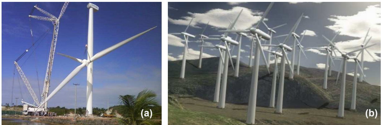
Figura 1.9: (a) Montagem das pás de um gerador. (b) Fazenda ou parque eólico
