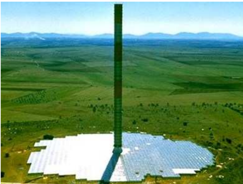
Figura 1.19: Chaminé solar em Manzanares, Espanha. Fonte: METEOROLOGICAL REACTORS (2012)
