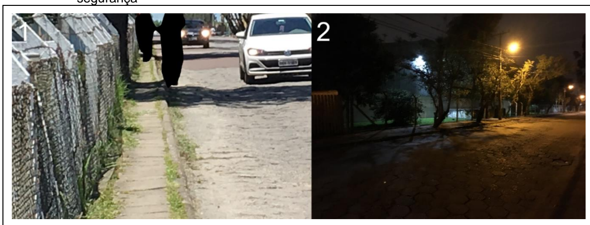
Figura 129: Fotografias do local específico de estudo 6 do bairro Afonso Pena: características de calçadas (1) e de iluminação (2) desfavoráveis à qualidade da paisagem relacionada à segurança
