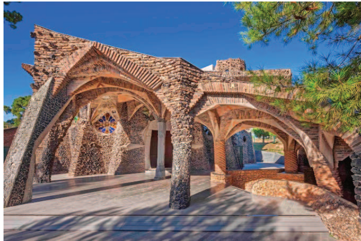
Figura 4.53 – Barcelona, Cripta da Colônia Guell.
