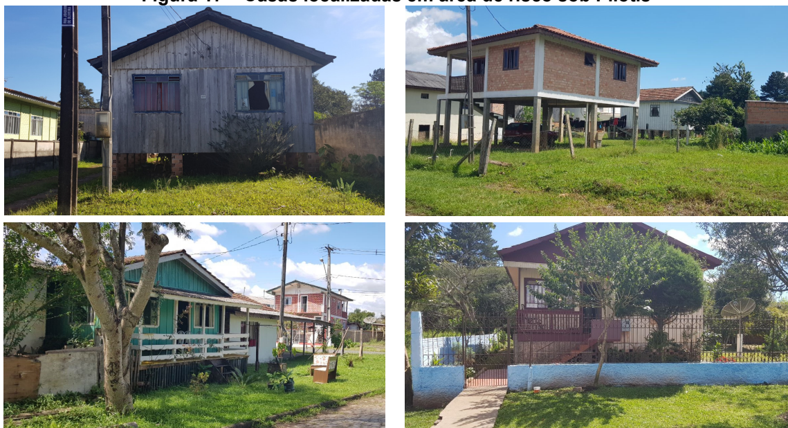
Figura 17 – Casas localizadas em área de risco sob Pilotis
