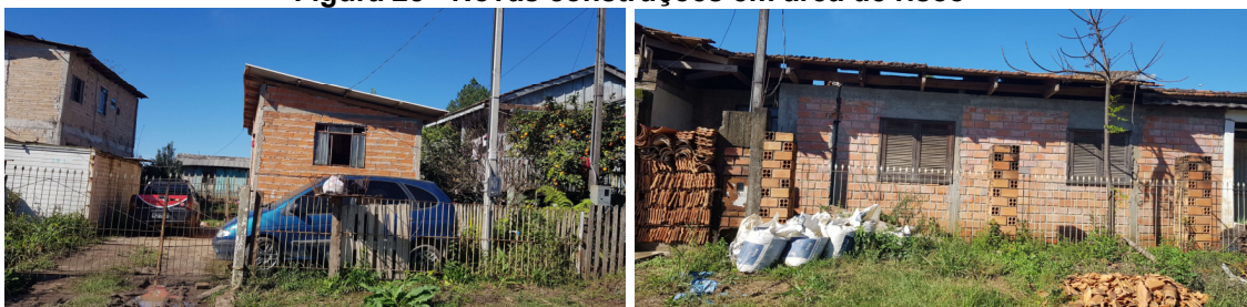
Figura 28 - Novas construções em área de risco
