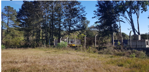
Figura 23 - Localização da ETE na área de risco
