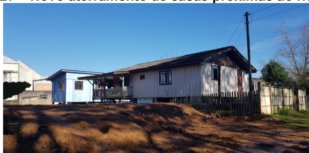
Figura 27 – Novo aterramento de casas próximas ao rio Iguaçu
