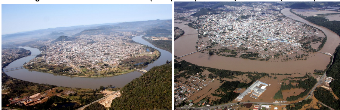
Figura 14 - Escoamento normal (à esquerda) e Inundação de 2014 (à direita)
