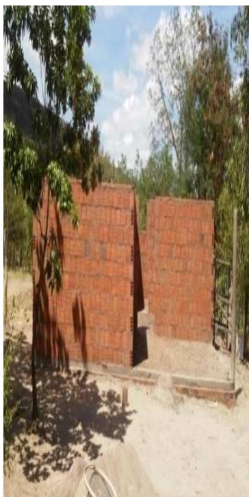
Figura 18 - Primeiras paredes das futuras moradias.
