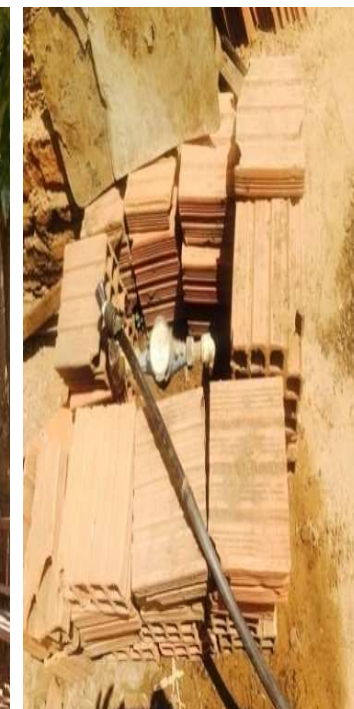
Figura 11 – Torneira com hidrômetro
