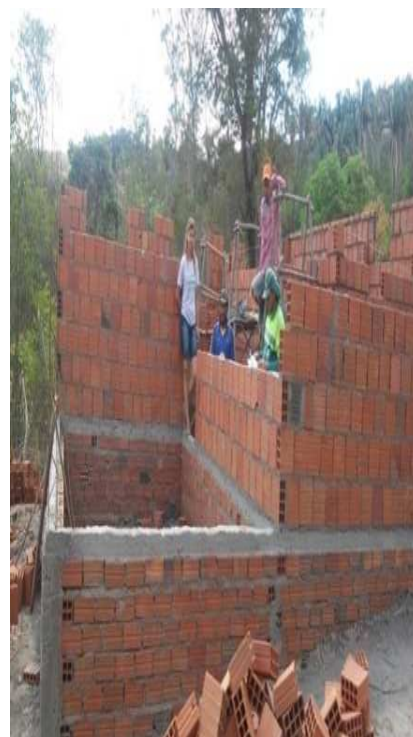
Figura 20 – Moradia construída com mão de obra local.
