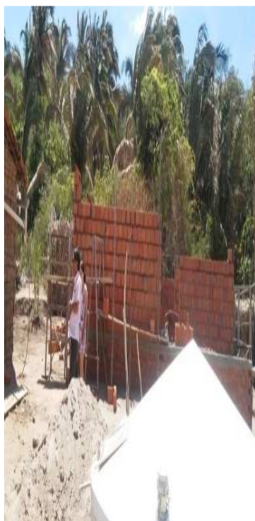
Figura 19 - Moradia construída junto com a cisterna calçada.
