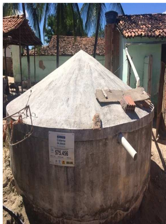
Figura 8 – Cisterna de placa com numeração de identificação, nas Guaribas em Crato
