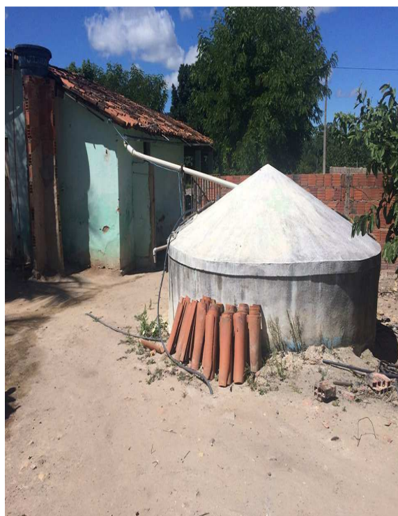
Figura 7 – Cisterna de placa no semiárido, construída nas Guaribas em Crato
