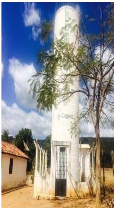
Figura 9 – Reservatório do Abastecimento de Água
