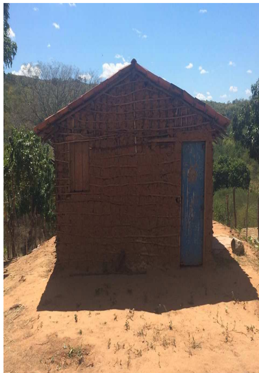
Figura 6 – Casa de taipa com telhado de cerâmica, nas Guaribas em Crato.
