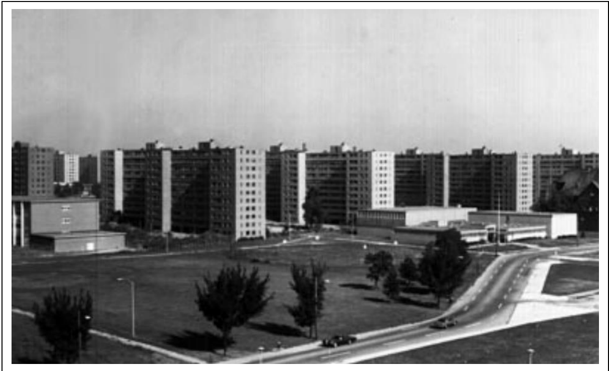
Figura 16: Vista geral do Conjunto Pruitt-Igoe em Saint Louis, Estados Unidos – meados do século XX
