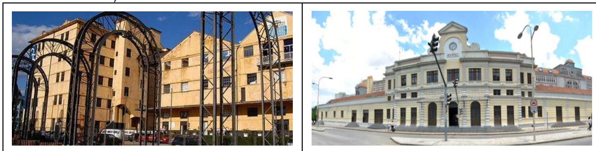
Figura 34: Vistas do Moinho Rebouças (esquerda) e do Museu Ferroviário (Shopping Estação – direita)
