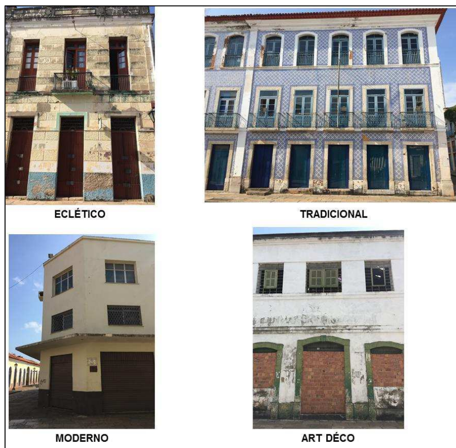
Figura 78: Vistas de exemplares de estilos arquitetônicos encontrados na Rua Portugal
