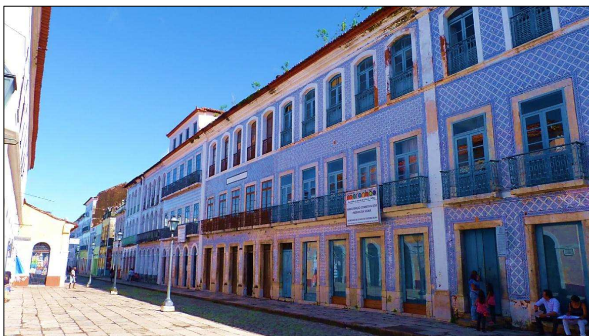
Figura 56: Vista de detalhes dos azulejos de revestimento de fachadas de prédios na Rua Portugal
