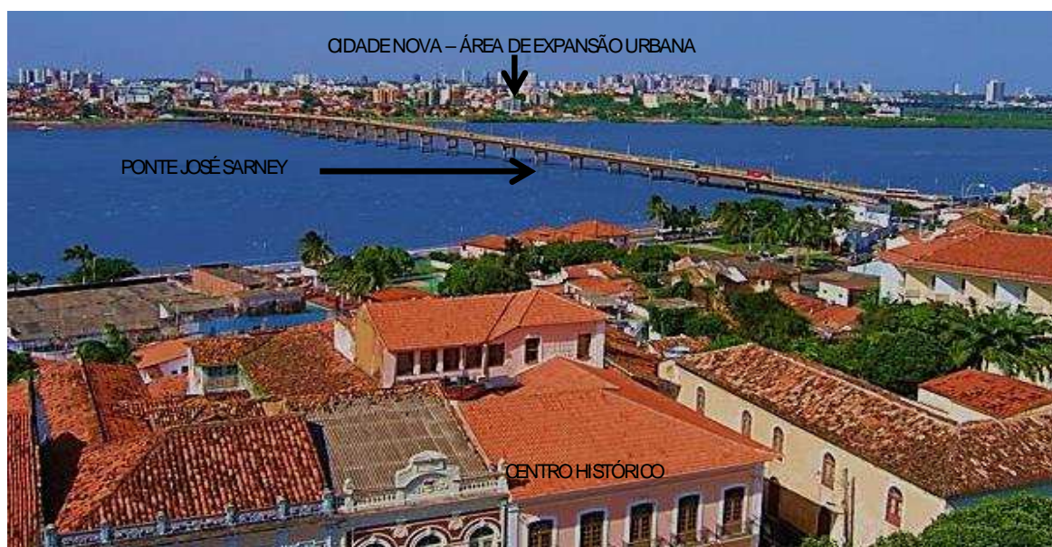
Figura 31: Vista da Ponte José Sarney com ligação do Centro Histórico à área nova da cidade de São Luís
