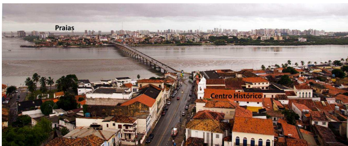
Figura 5: Vista da Ponte José Sarney conectando o centro histórico às praias de São Luís, Maranhão
