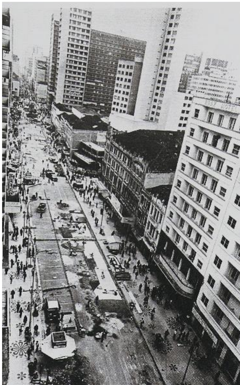
Figura 5 – Obra de execução do calçadão da Rua XV de Novembro em 1972 Fonte: Paraná, 2016.
