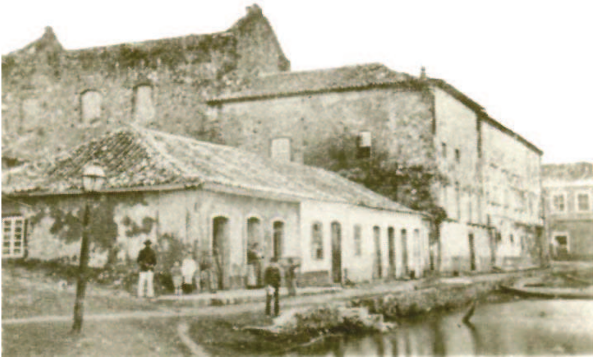
Fachada do colégio em Paranaguá
